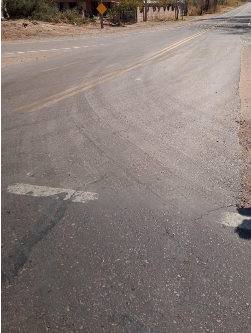
Ilustración 35 Situación actual del cruce entre la RP 167 y RN143
