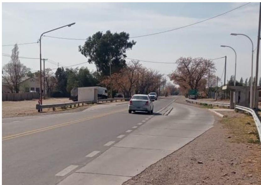
Ilustración 30 iluminación actual en la intersección.
