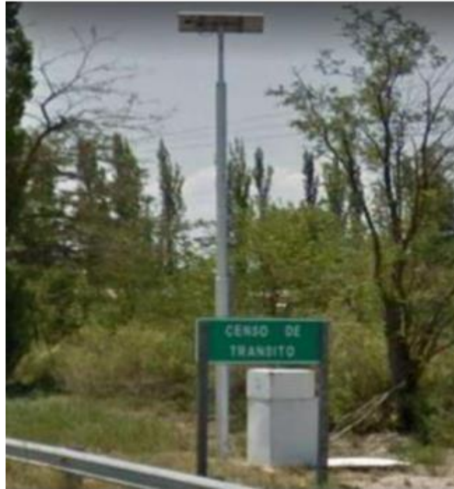
Ilustración 48 : Estación permanente sobre RN143 – San Rafael – Mendoza.
