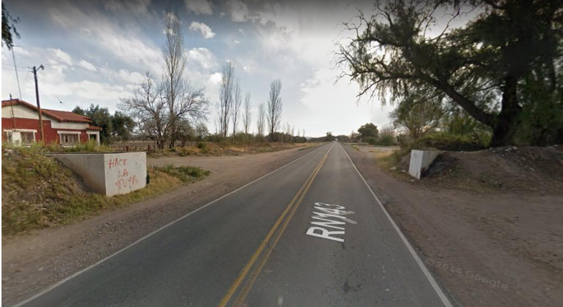
Ilustración 8 Alcantarilla RN N°143.
