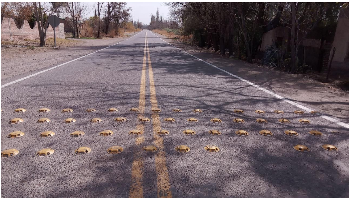
Ilustración 33 Reductor de velocidad RP 167
