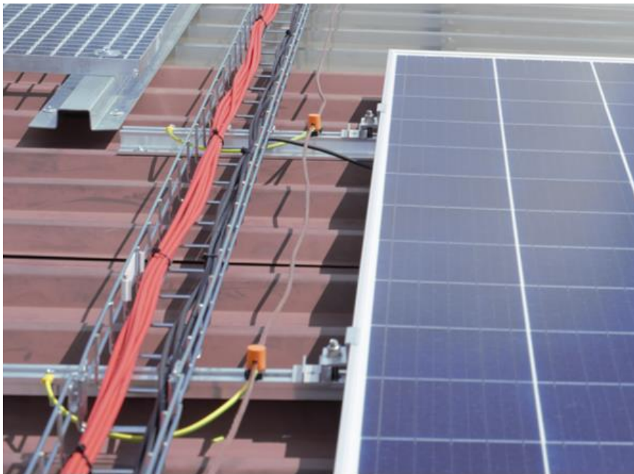
FIGURA N°75 : Conductor solar sobre bandejas tipo rejillas.
