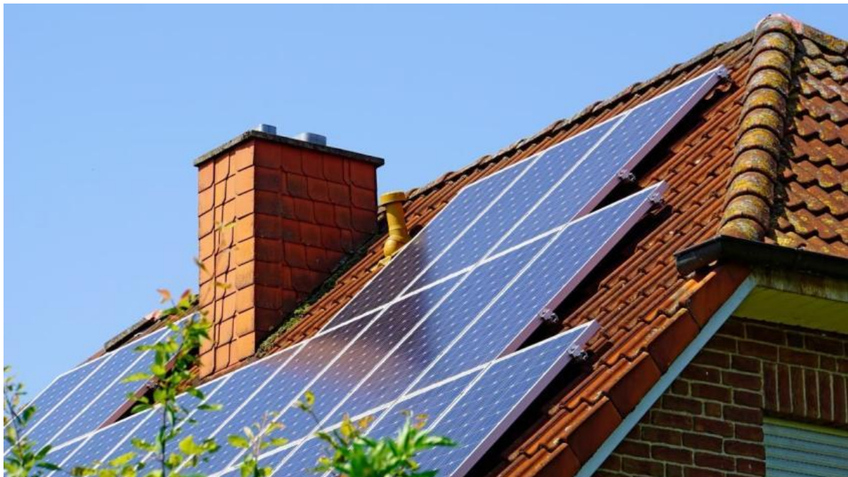
FIGURA N°29 : Paneles solares parcialmente integrados.
