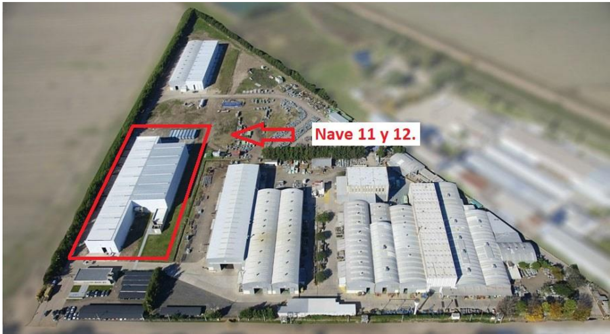
FIGURA N°41 : Imagen aérea de naves 11 y 12.
