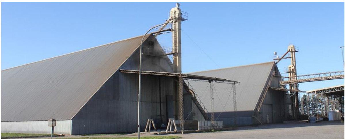
Figura 1-09: Celdas de almacenamiento
