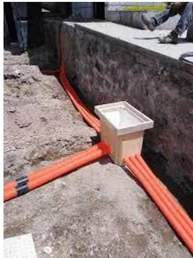
Ilustración 43 - Referencias de cajas estancas – Extracción GEWISS
