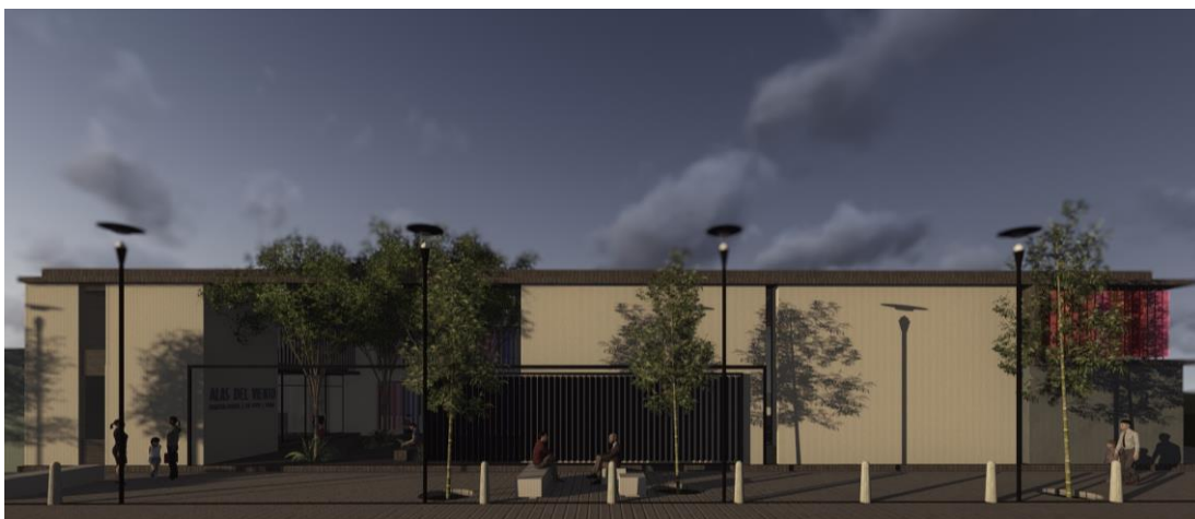
Figura 51. Vista general desde vía pública. Fuente: Elaboración propia
