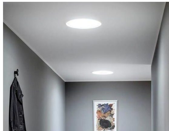
Figura 24. Aplicación lumiducto en pasillo. Fuente: (Vazquez J. 2019)
