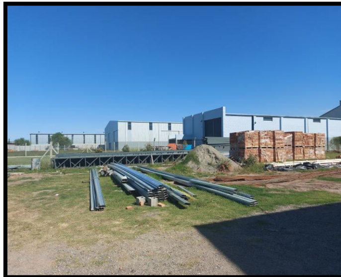
Figura N°17: Depósito mallas, hierros, estructuras de galpones terminados y ladrillos.
