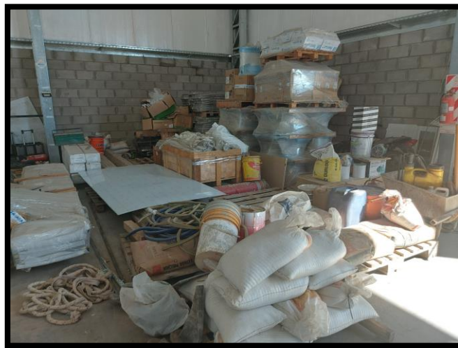
Figura N°7: Depósito de materiales de obra civil.
