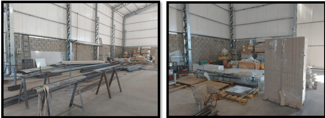
Figura N°33: Sectores de trabajo.
