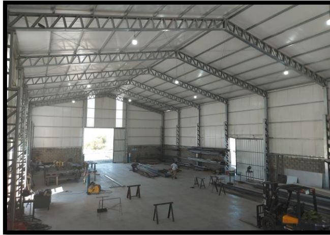
Figura N°6: Interior del galpón.
