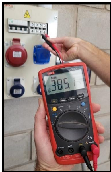
Figura N°53: Verificación de tensión en tablero secundario.
