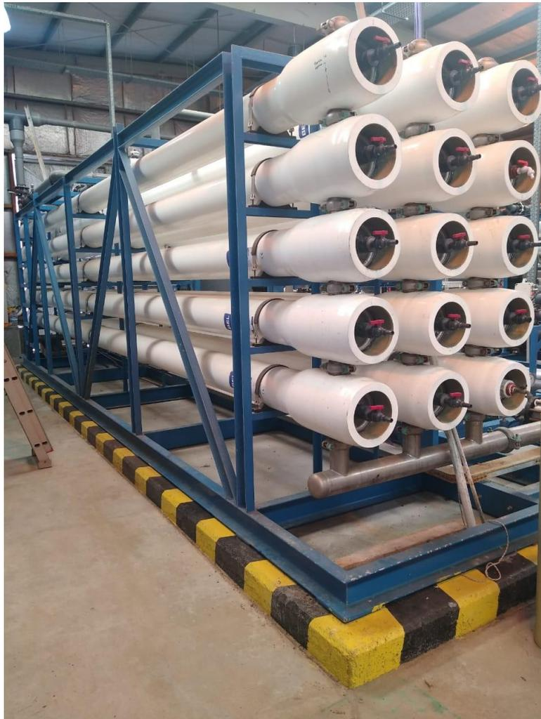
Figura 1.5. Módulo de membranas de ósmosis .
