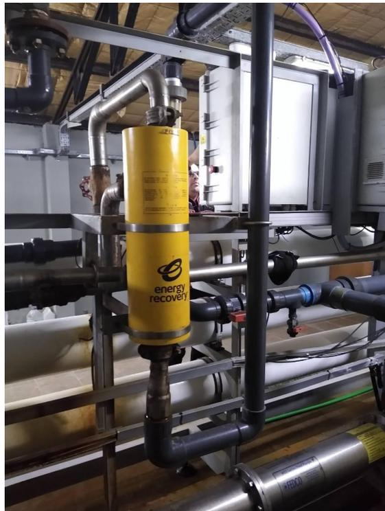
Figura 2.18. Recuperador de Energía montado en el sistema de cañerías del sistema de O
