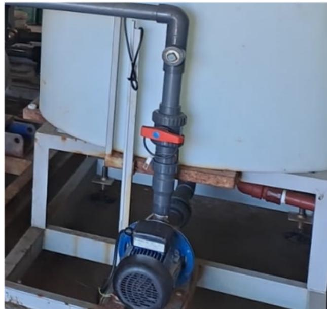
Figura 2.23 y 2.24 Tanque de agua de enjuague - Bombas de lavado de filtros
