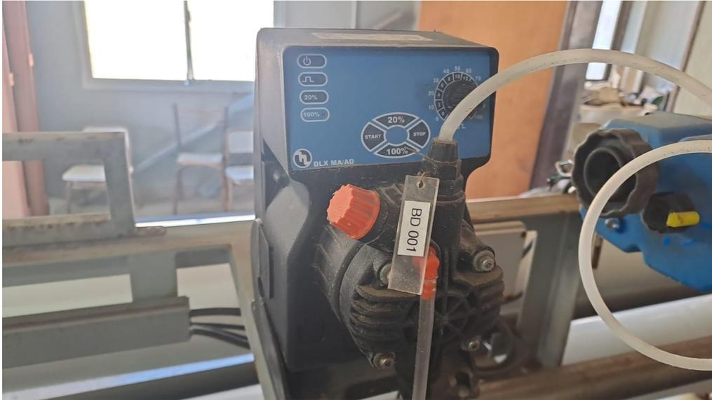
Figura 2.22. Bomba Dosificadora De antiincrustante
