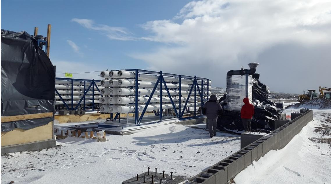
Figura 2.39 Montaje Planta OI
