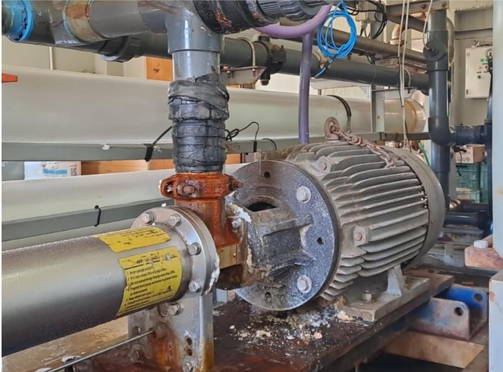
Figura 2.12 Bomba de alta presión
