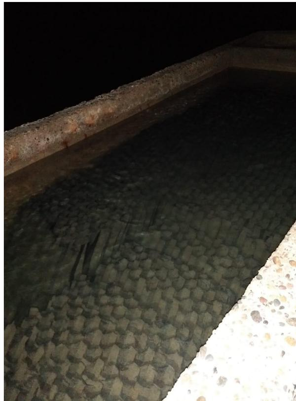
Figura 2.19y 2.20 Decantadores de cemento contra corriente
