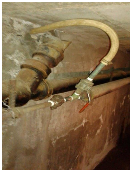
Figura 8: Instalación improvisada.
