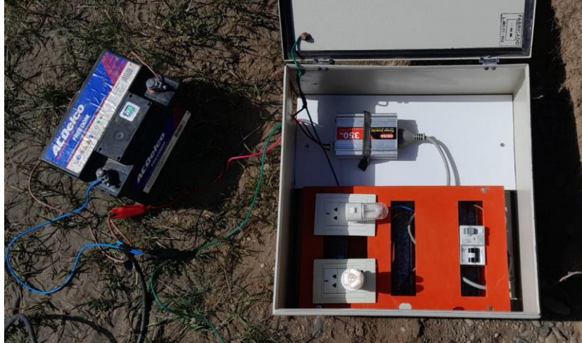
Ilustración 55- Instalación del tablero eléctrico, batería y conexiones pertinentes
