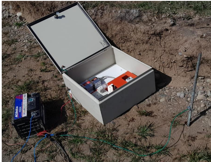
Ilustración 56- Instalación del tablero eléctrico, batería y puesta a tierra
