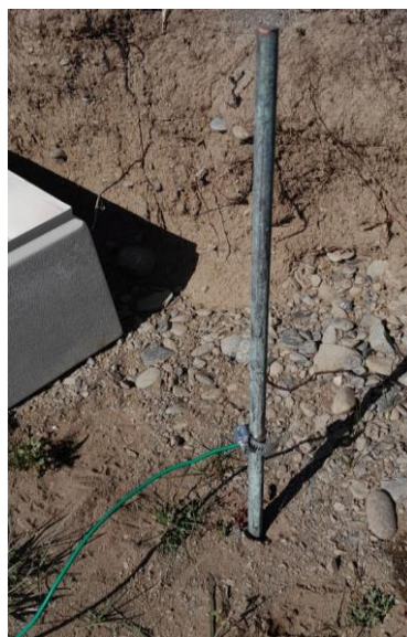
Ilustración 49- Jabalina de cobre
