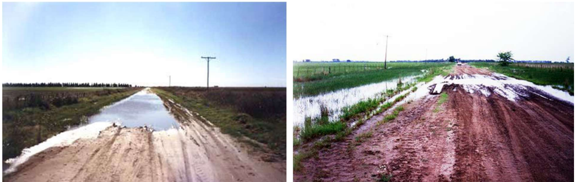
Figura 47 – Ejemplo de caminos intransitables por falta de perfil transversal
