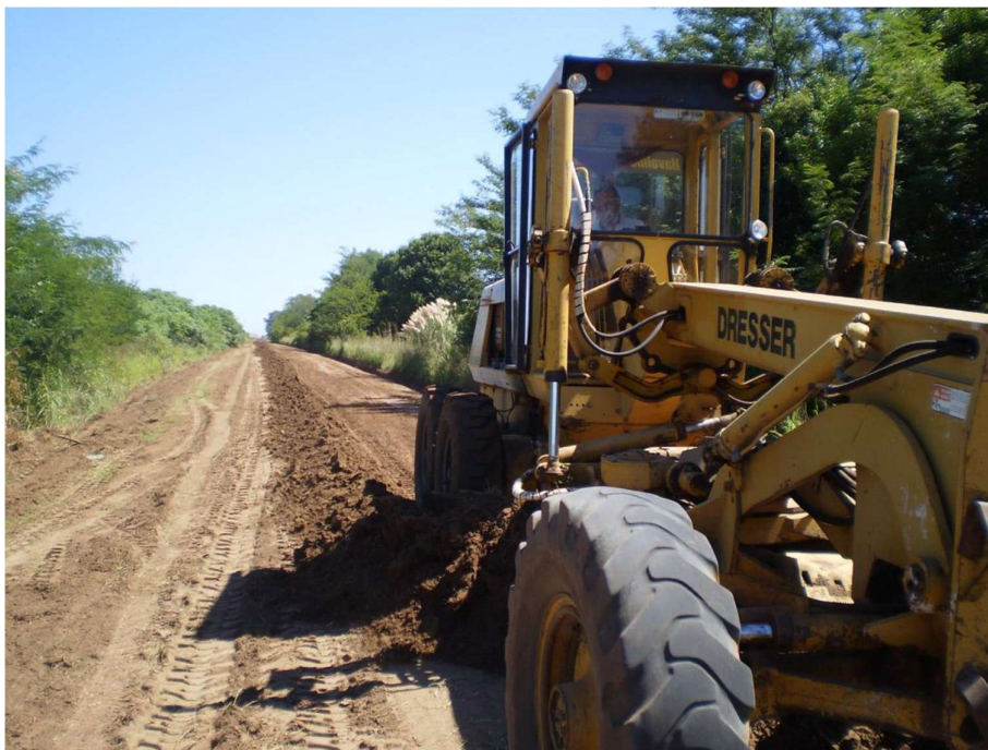
Figura 60 – Perfilado o abovedamiento de la red (sin extracción Lateral) y borrado de huellas
