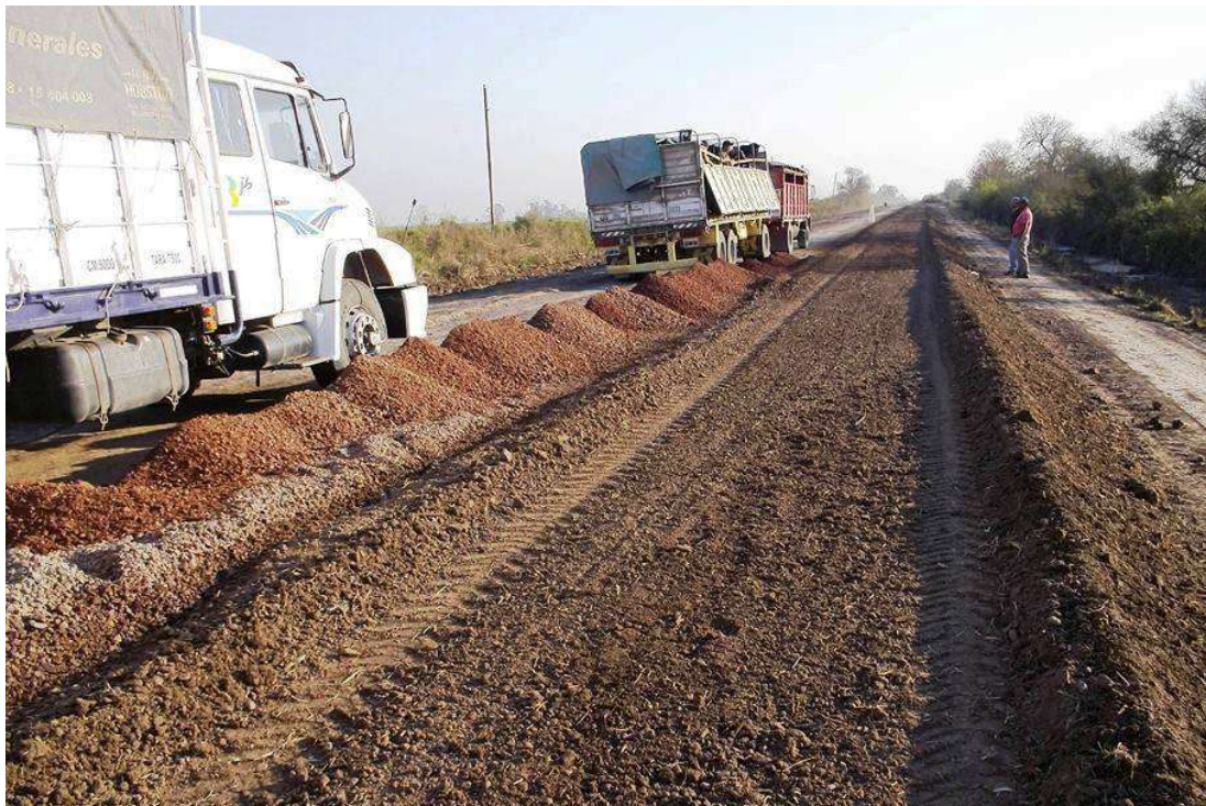
Figura 52 – Ejemplo de estabilizado o afirmado granular
