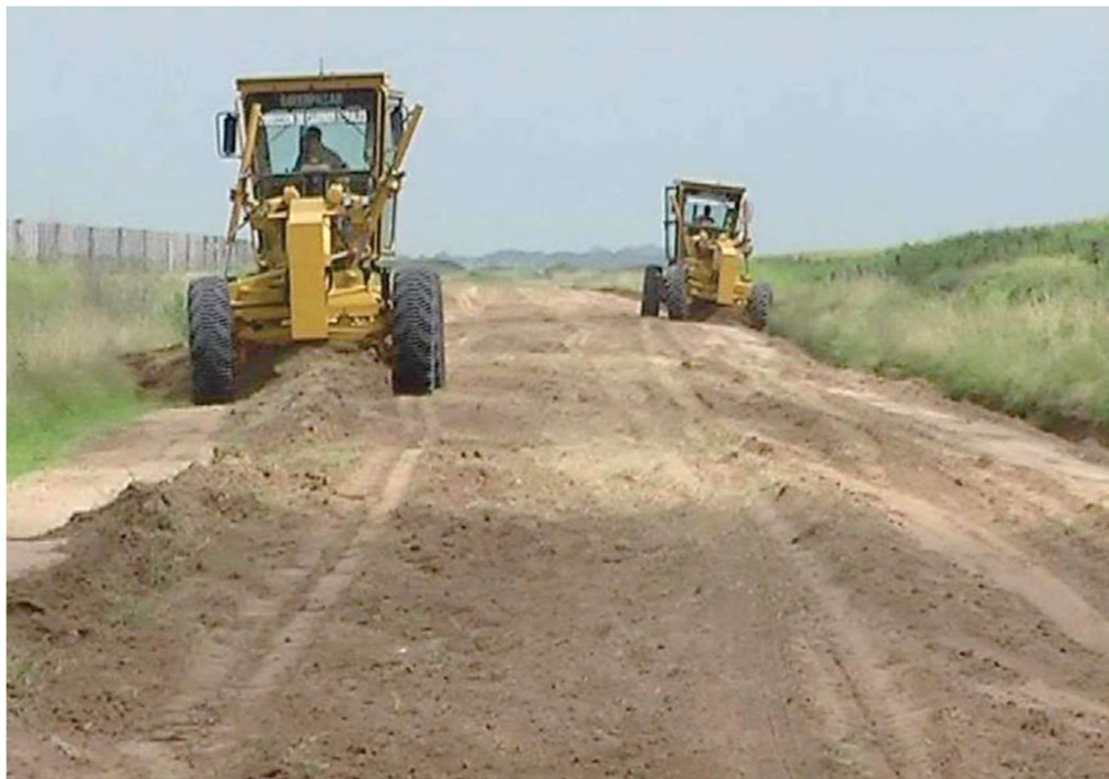
Figura 61 – Perfilado o abovedamiento de la red con extracción lateral
