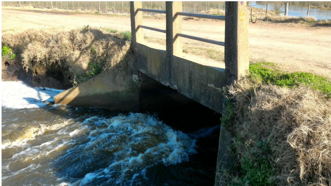
Figura 24 – Puente de Mimiza – agosto 2017
