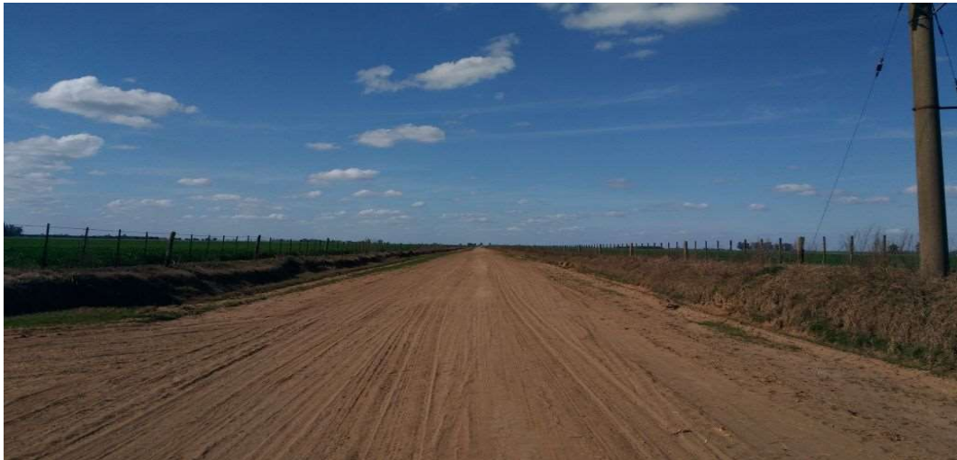
Figura 42 – Estado actual Tramo II del Camino CM01-Z4
