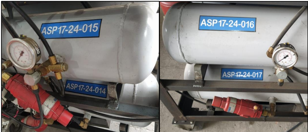
Figura 36: Depósitos de aire de la Unidad de Ensayo, señalizados bajo norma. Fuente: Fotografías tomadas en la empresa.
