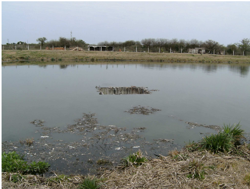
Foto 1: Vertedero de laguna aeróbica, trabajando al máximo.
