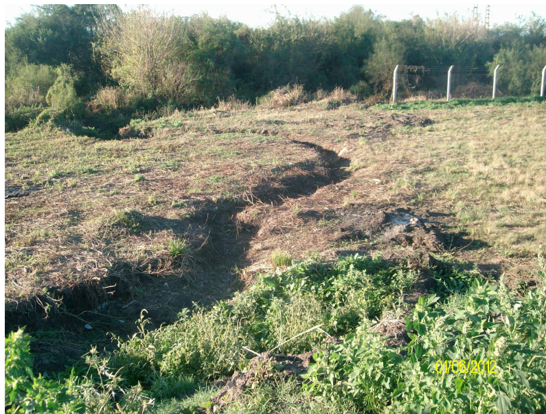
Foto 3: Sangría construida paralela a la salida al A° Casafus.
