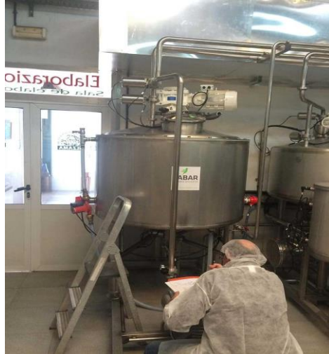
Imagen N° 5: Tanque receptor de leche
