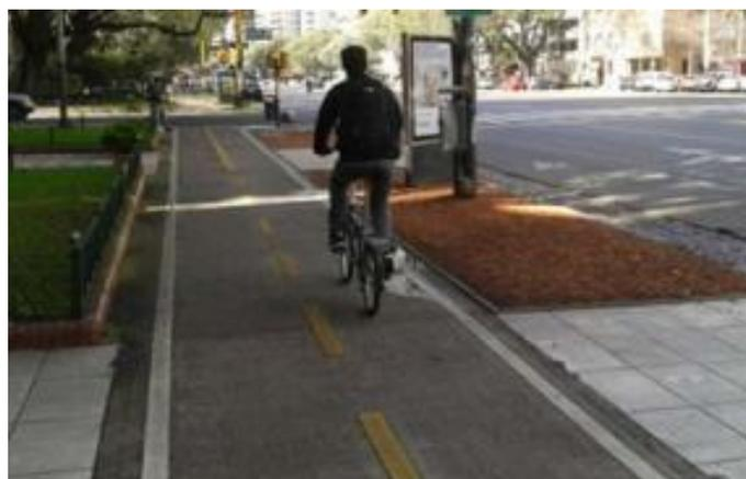
Figura 3.4.F.- Eje divisorio bicisenda. Fuente: Lineamientos generales Ciclovías y Bicisendas. Ministerio de Transporte Argentina
