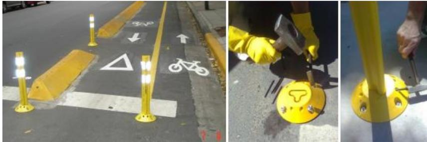
Figura 3.4.O. - Emplazamiento de delineadores rebatibles. Fuente: Lineamientos generales Ciclovías y Bicisendas. Ministerio de Transporte Argentina
