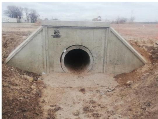
Figura 10.3.F. – Se utilizarán cabezales premoldeados
