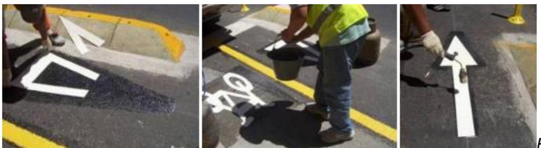
Figura 3.4.Ñ - Aplicación imágenes preformadas. Fuente: Lineamientos generales Ciclovías y Bicisendas. Ministerio de Transporte Argentina
