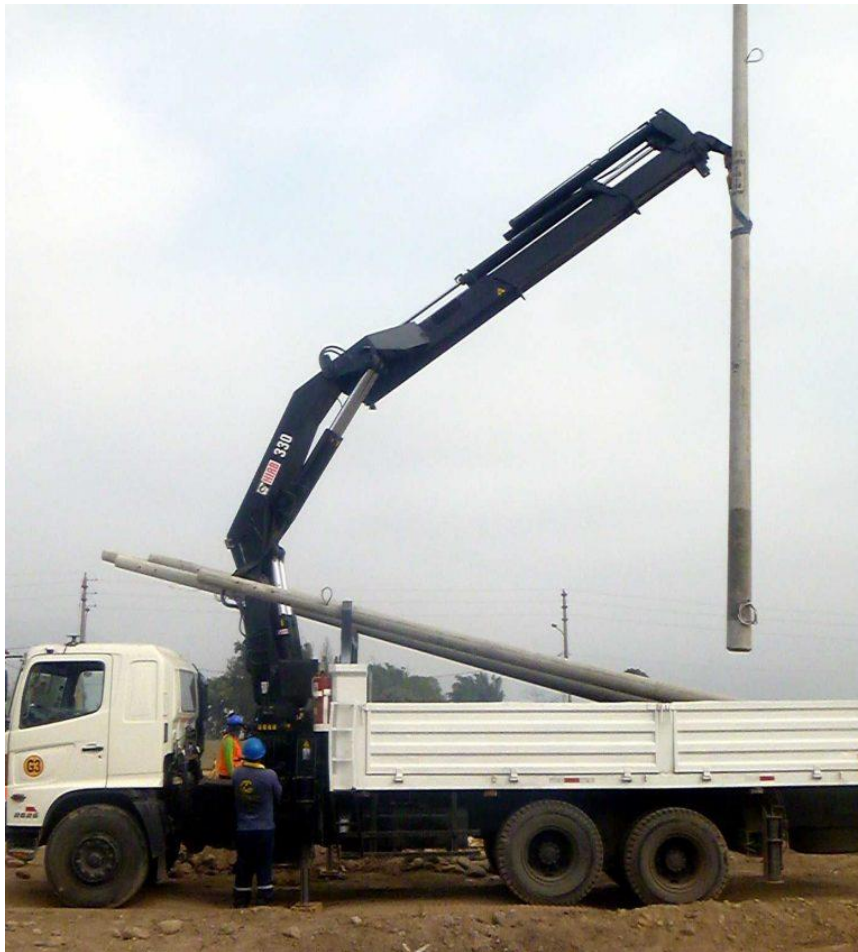
Figura 60, Selección del transporte, camión transporte e izado de postes.
