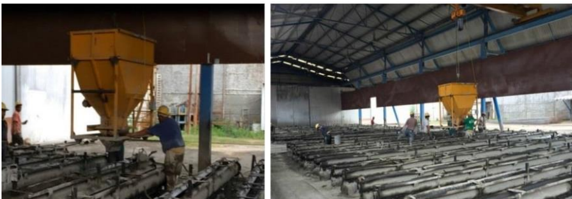
Figura 36, Vaciado del concreto.
