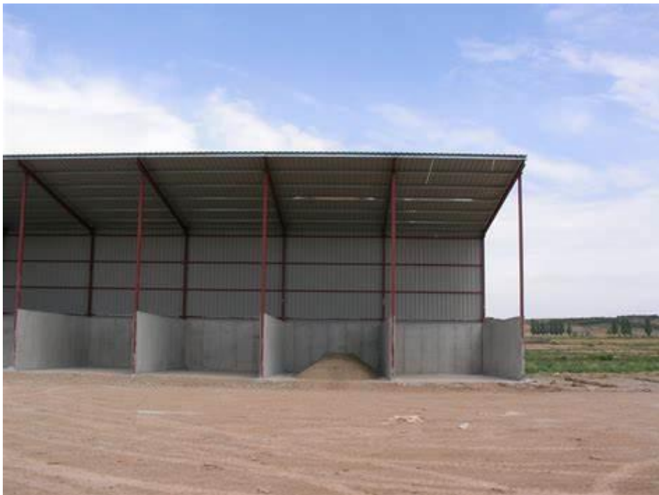
Figura 30, Acopio de piedra.
