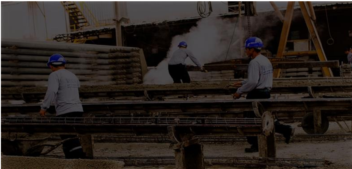
Figura 33, Armadura de poste de hormigón.
