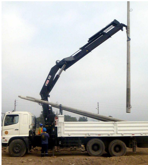
Figura 4, camión de transporte e izado.
