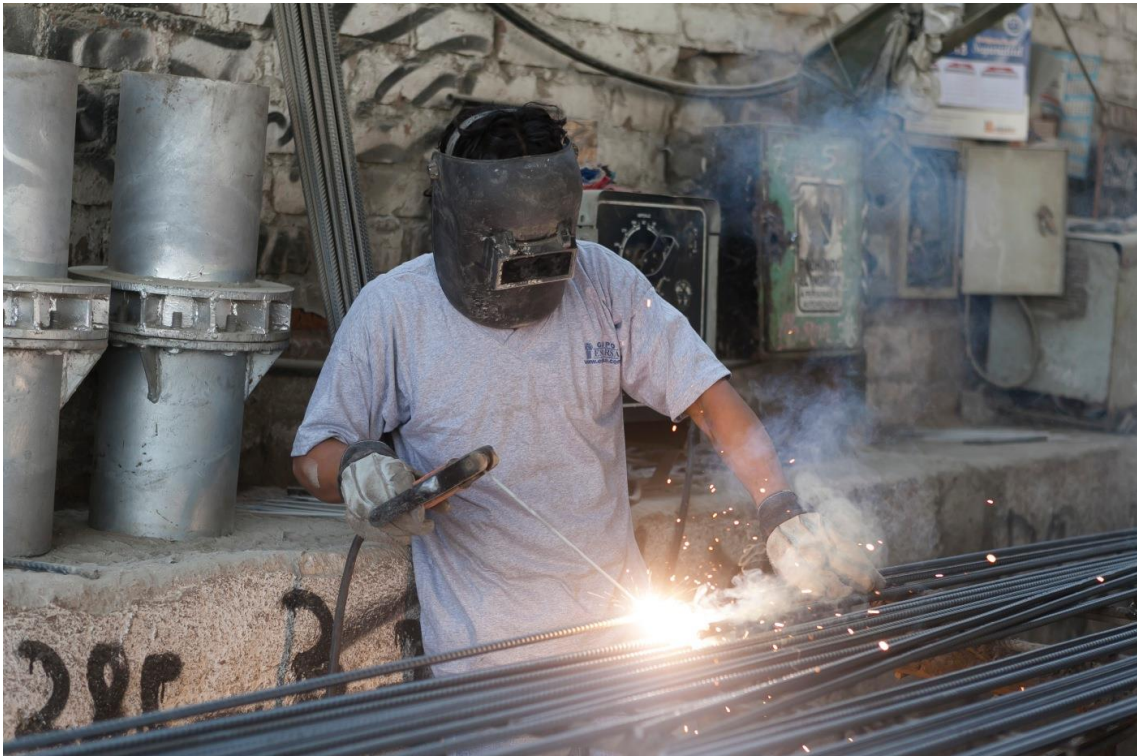
Figura 34, Soldadura de armadura.
