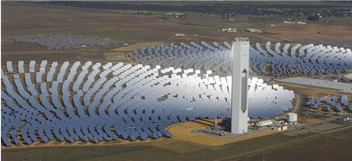
Figura I. 4. Planta de generación de energía eléctrica por EST (Central de Energía Solar Solnova de 150 MW situada en Sanlúcar la Mayor, España).
