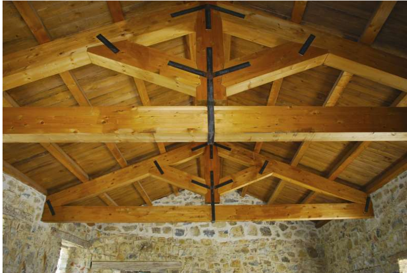
Figura 6.1 – Cercha “tipo española” – Fuente: Sinergia Tech
