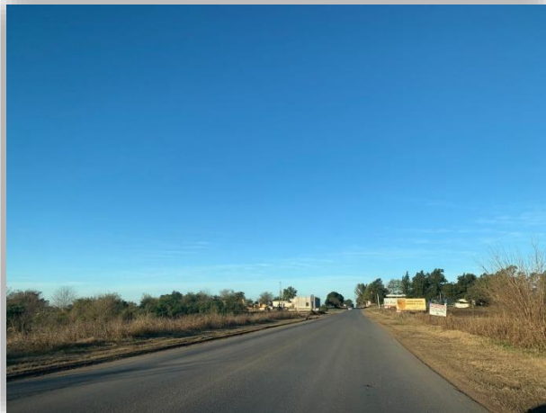
Ilustración 48- Ausencia de señalización horizontal
