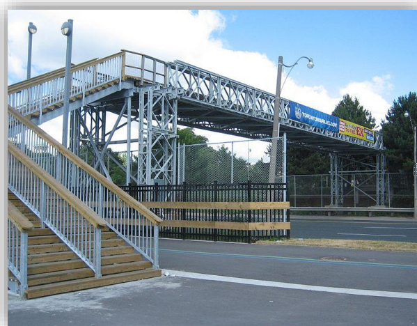
Ilustración 117- Puente peatonal metálico
