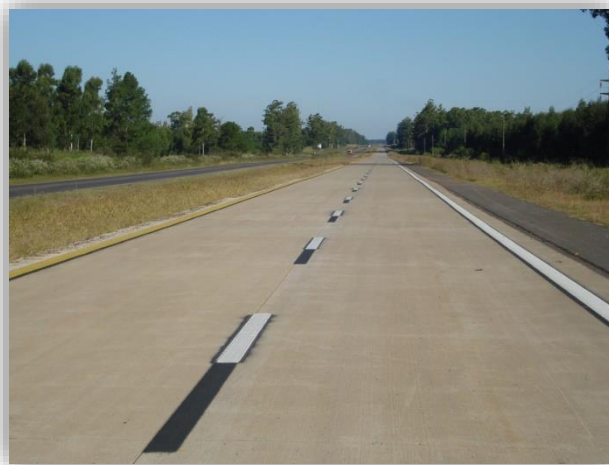
Ilustración 124- Vía de pavimento rígido
