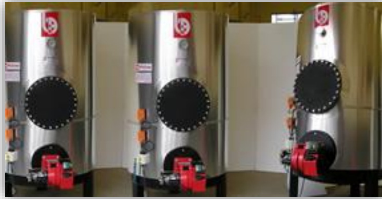
Ilustración 83- Termotanques de alta recuperación
