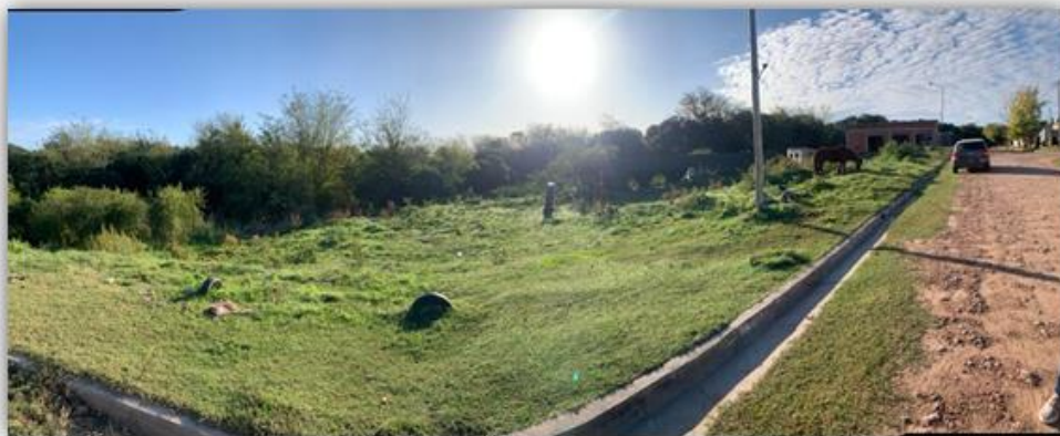
Ilustración 37- Vista panorámica de planta de tratamiento
