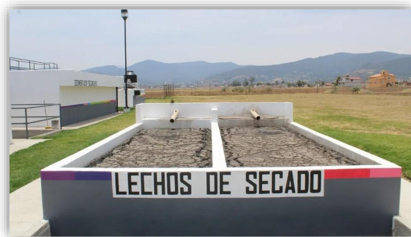
Ilustración 110- Lechos de secado
