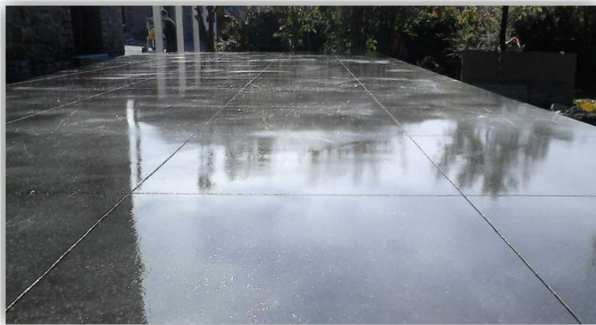
Ilustración 78- Hormigón pulido antideslizante
