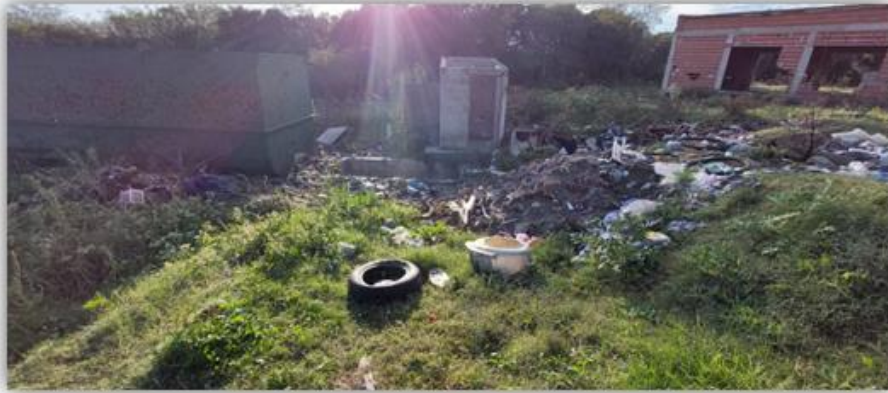
Ilustración 38- Estado actual planta de tratamiento
