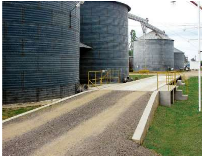
Imagen 10.7 – Báscula instalada cercana a los silos
