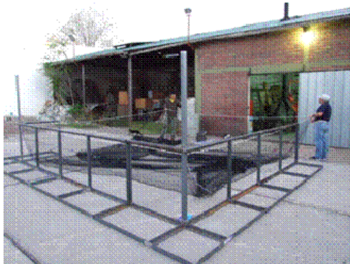
Figura 5. Aspectos de la construcción de la estructura del módulo tecnológico
