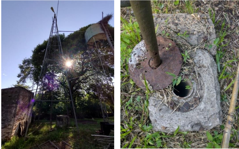
Figura 7: Ubicación y diámetro de pozo de bombeo en desuso
