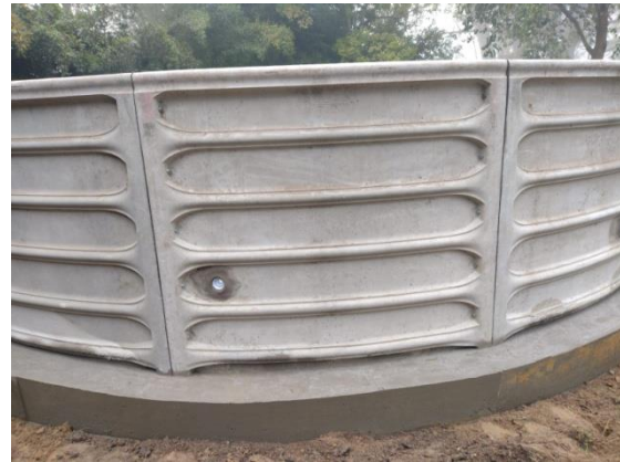
Figura 57: Proceso de hormigonado de tanque australiano.
