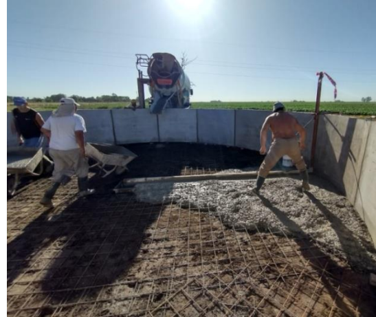
Figura 56: Proceso de hormigonado de tanque australiano.
