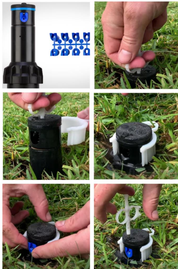
Figura 63: Instalación de boquillas de difusión.
