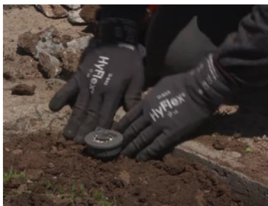
Figura 62: Verificación de emisor instalado correctamente.
