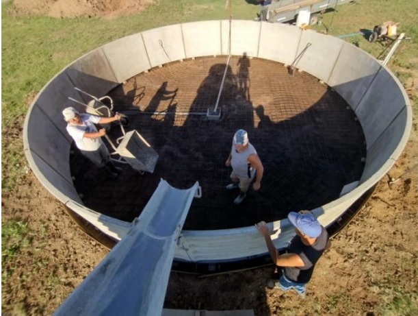
Figura 56: Proceso de hormigonado de tanque australiano.
