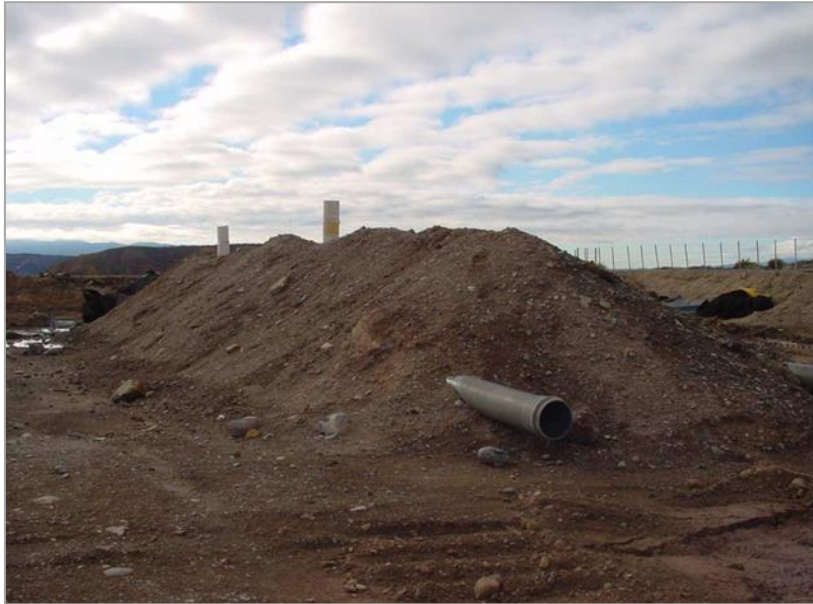
Foto 1-2. Biopila típica en construcción con cañerías de aireación vertical y horizontal para estimular la degradación de hidrocarburos en suelos contaminados. (Mendoza 2018)
