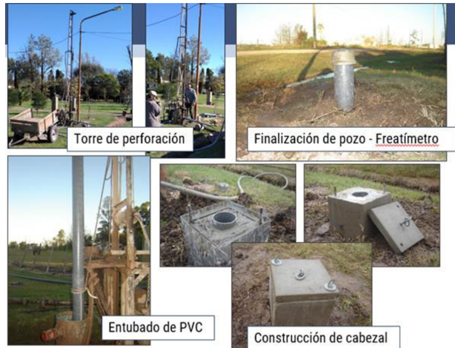
Figura. 6: Fotografías del proceso de Perforación de un freático y su cabezal.
