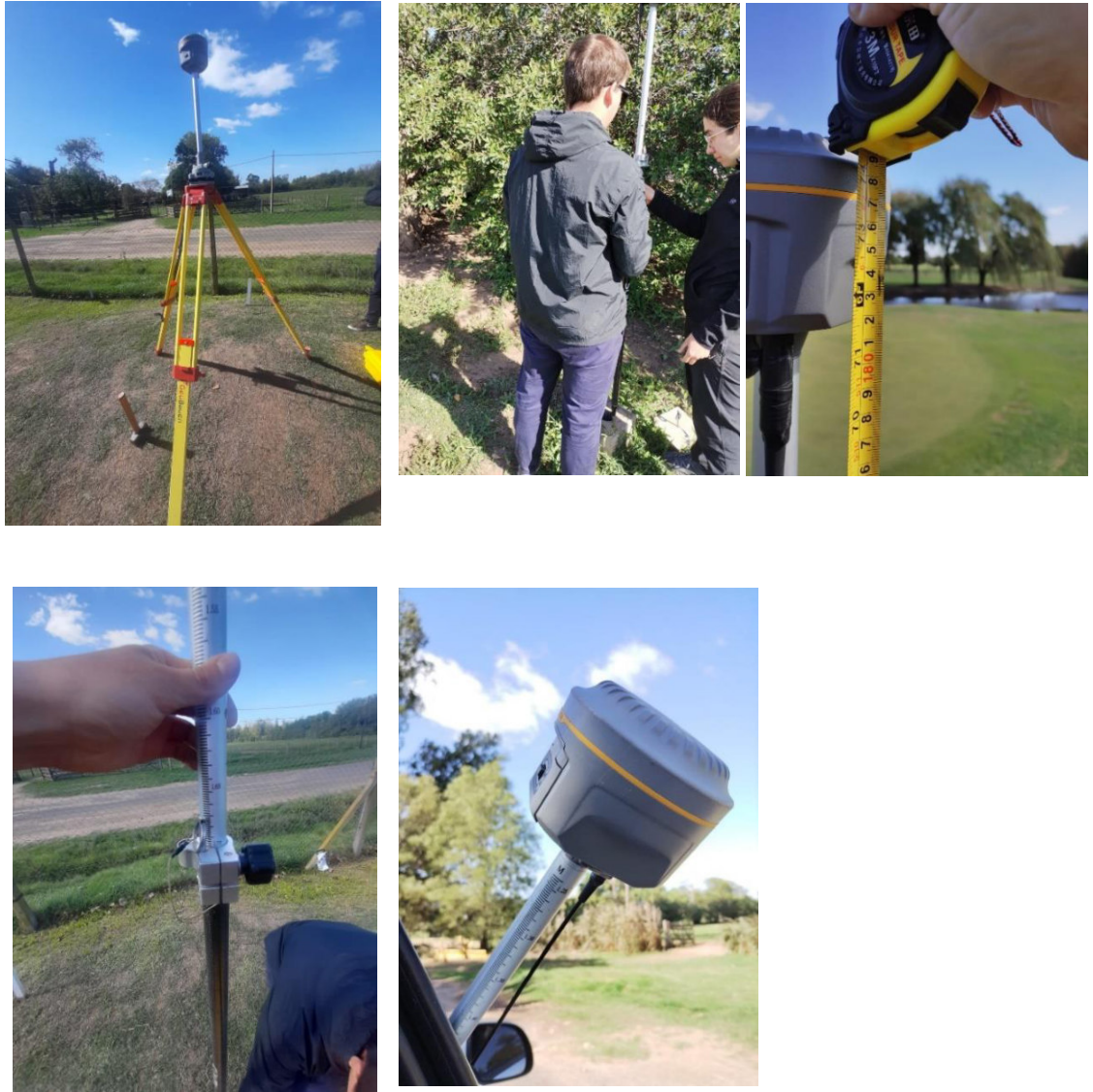
Figura 18: Nivelación con GPS Barrio Cumelén. Estación base instalada en Polo Club.
