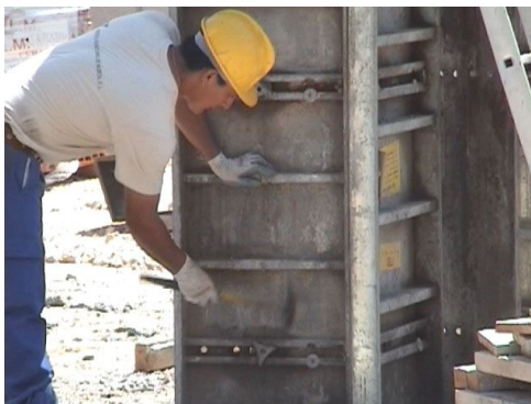
Figura 6.2.4: Encofrado metálico.
