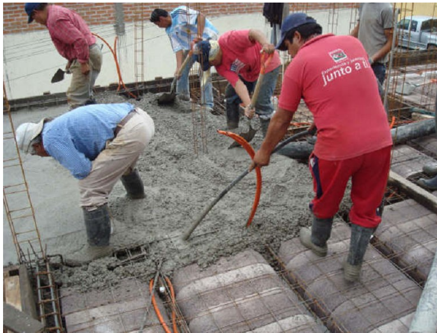
Figura 6.3.1.5.1: Hormigonado de losa.
