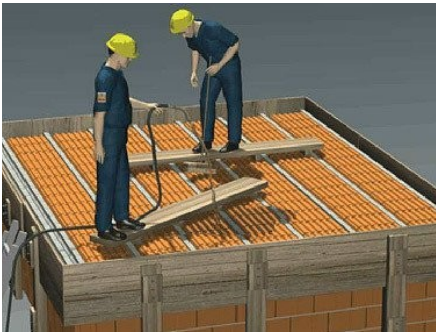
Figura 6.3.1.4.1: Mojado de superficie para mejorar adherencia de hormigón.
