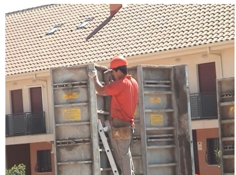
Figura 6.2.5: Encofrado metálico.
