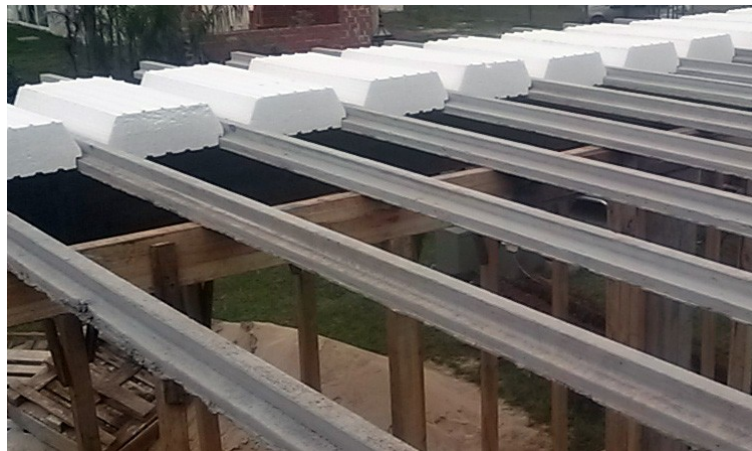
Figura 6.3.1.2.1: Disposición de viguetas.
