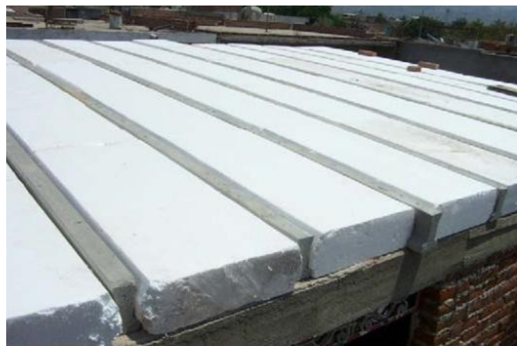
Figura 6.3.1.2.2: Disposición de bovedillas.
