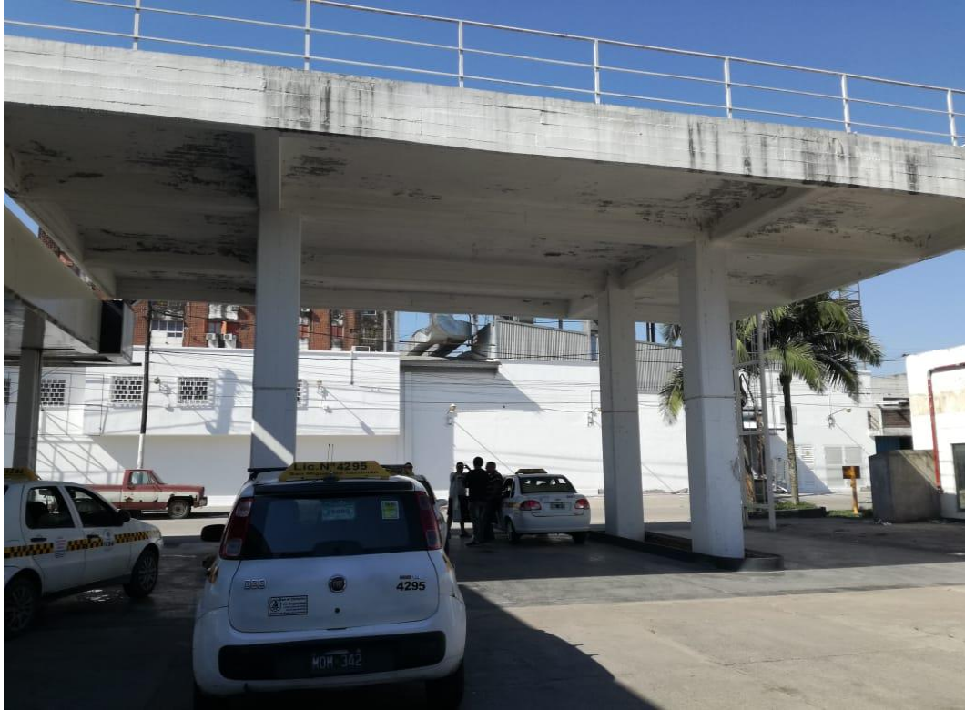
Vista de la zona de futura Instalación de venta de GNC
