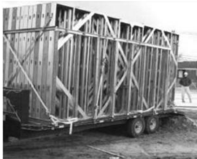
– imagen 25: paneles prefabricados transportados a obra. (Sarmanho Freitas & Moraes de Crasto, 2007).
