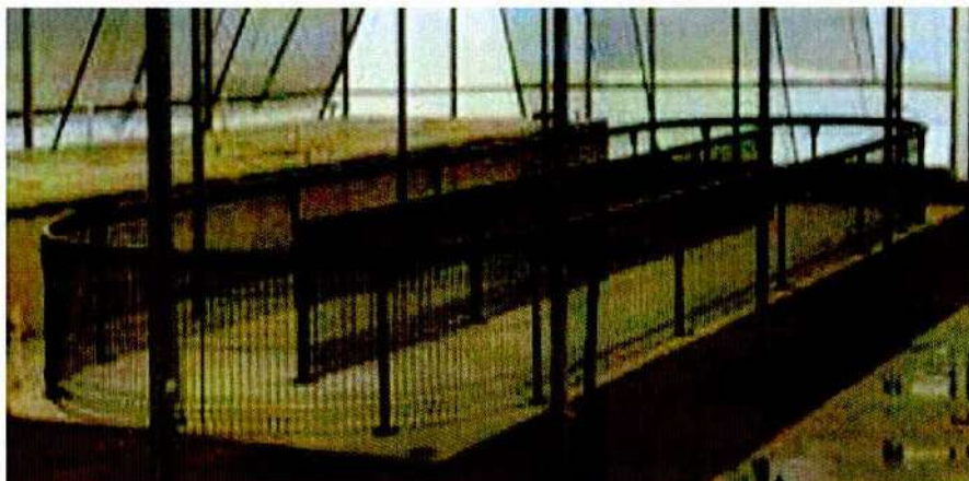
Imagen 26 Construcción de Piletas
