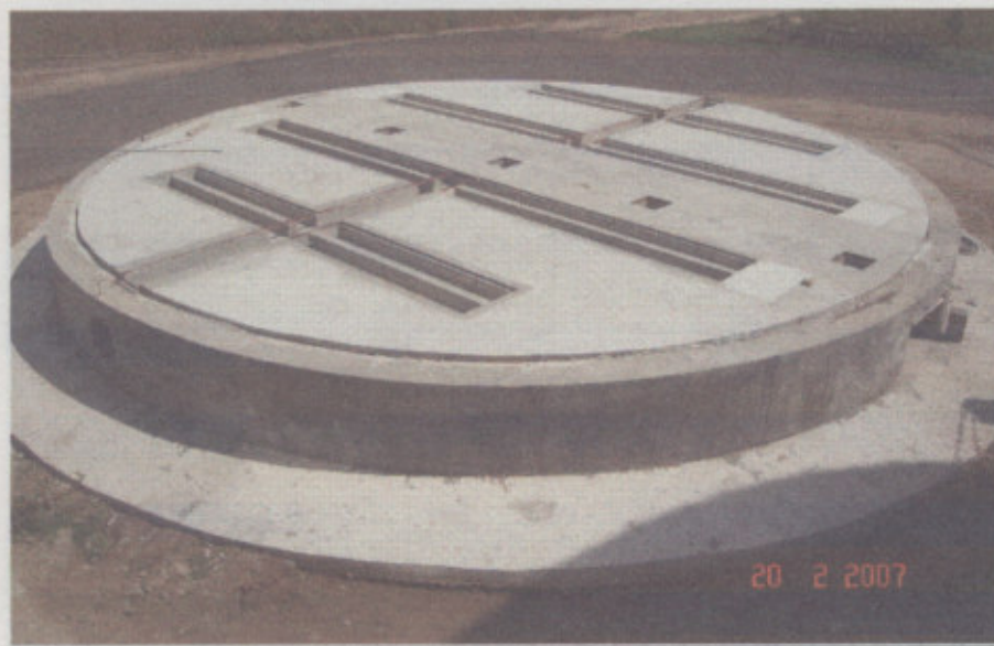
Fig. 2 – Obra civil de silo fondo plano-Bocas de vaciado y canales de aireación
