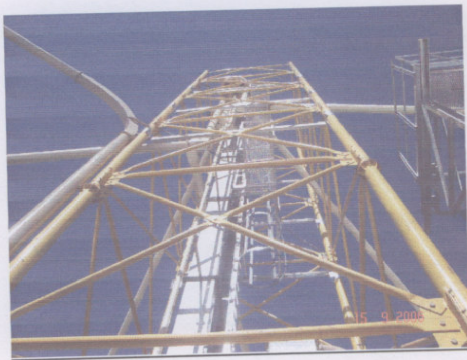
Fig. 72- Torre autoportante para elevador a cangilones
