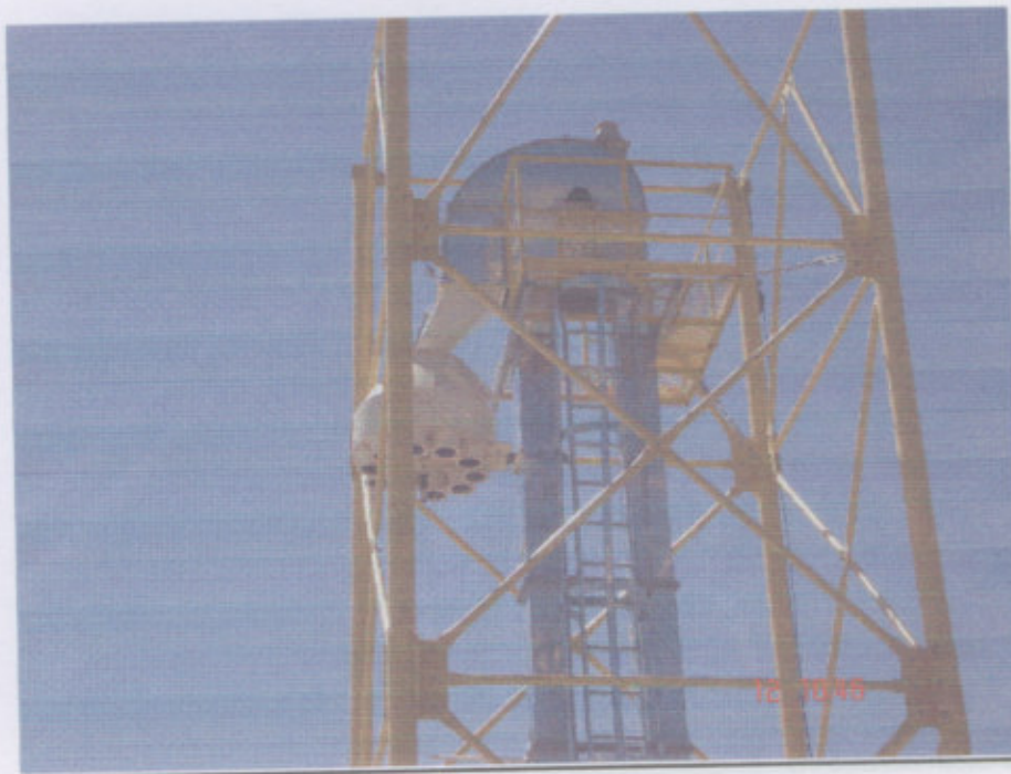
Fig. 70- Torre autoportante para elevador a cangilones
