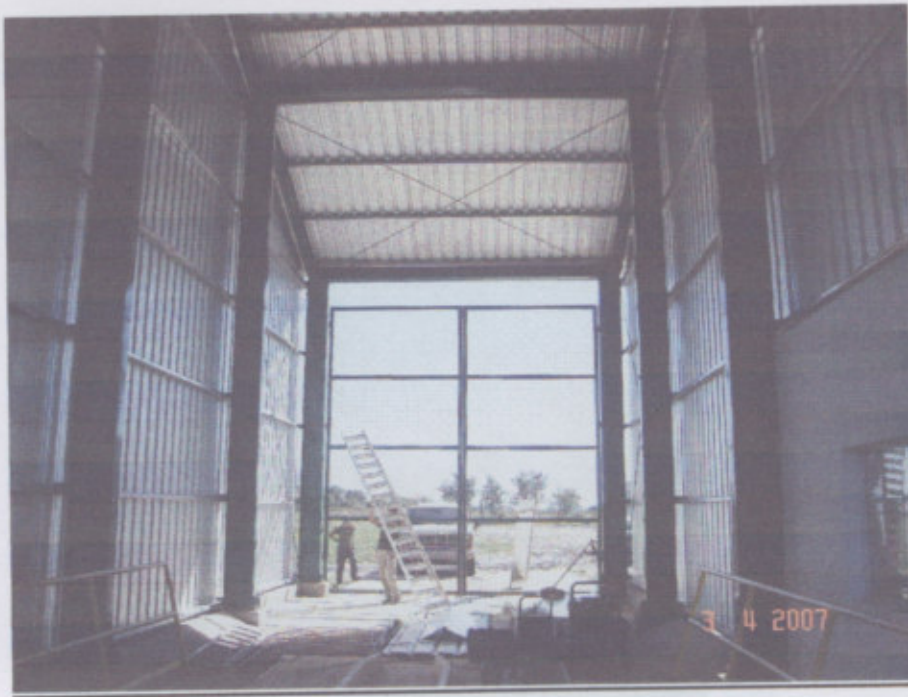
Fig. 41 –Galpón Cubretolva –Colocación de portones
