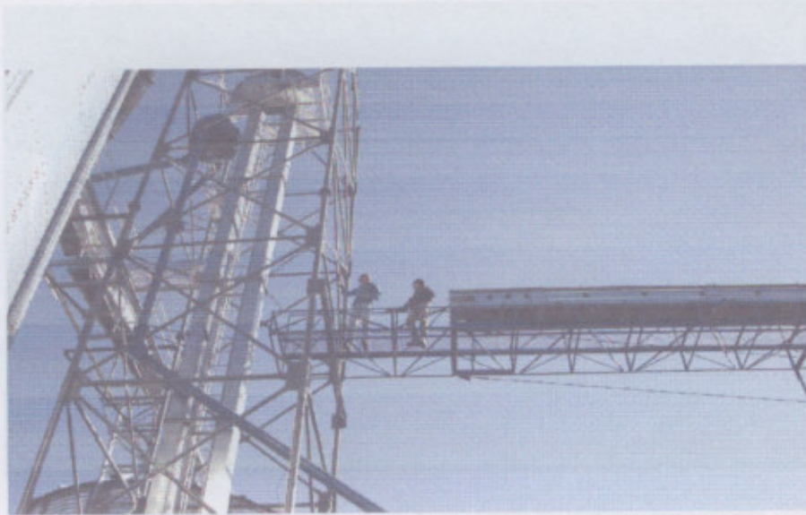
Fig.74- Pasarelas de servicio para transportes aéreos
