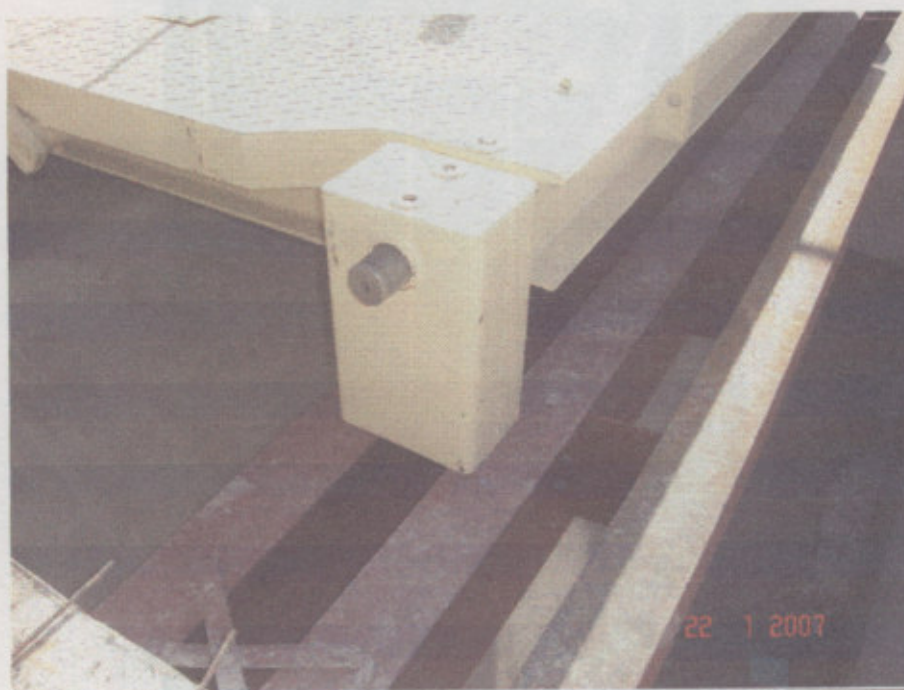
Fig. 18 -Apoyo de Plataforma Volcadora sobre perfleria
