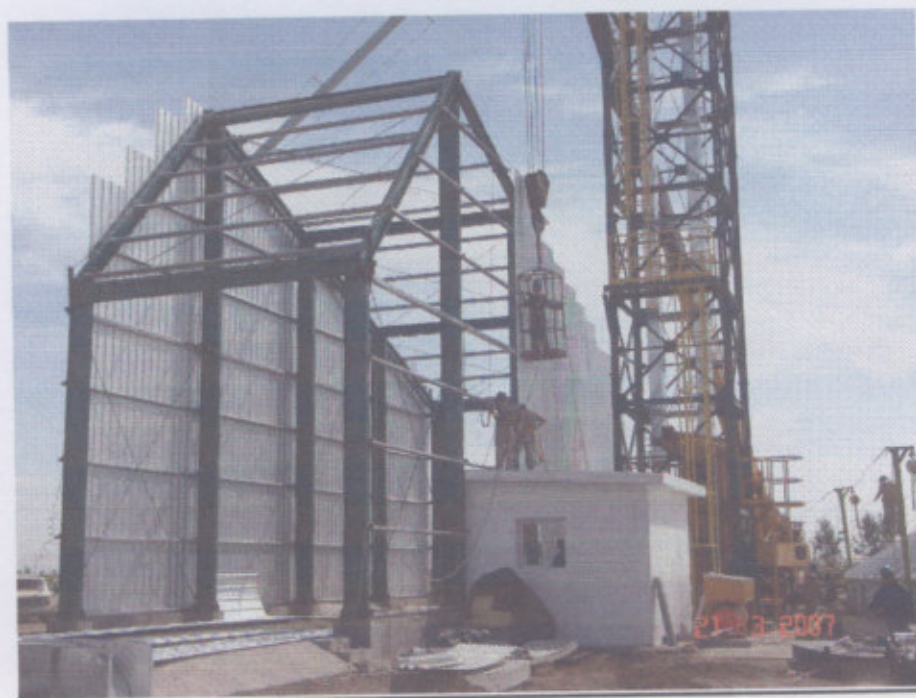
Fig. 38 -Galpón Cubretolva -Colocación de chapas laterales
