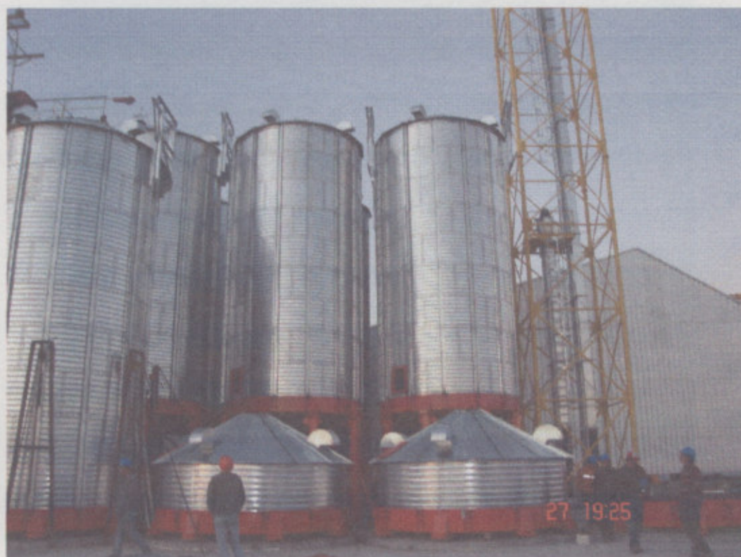
Fig. 11 –Silos de Húmedo y Tempering-Montaje
