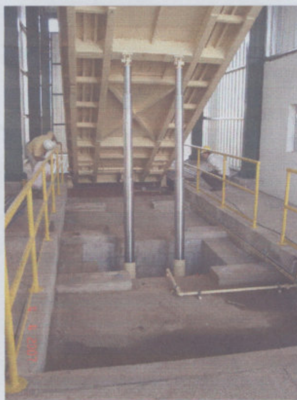
Fig. 20 –Plataforma Volcadora – Cilindros hidráulicos
