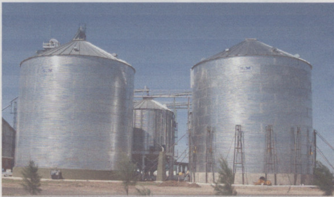
Fig. 6-1 –Silos de depósito-Capacidad 1450 TN
