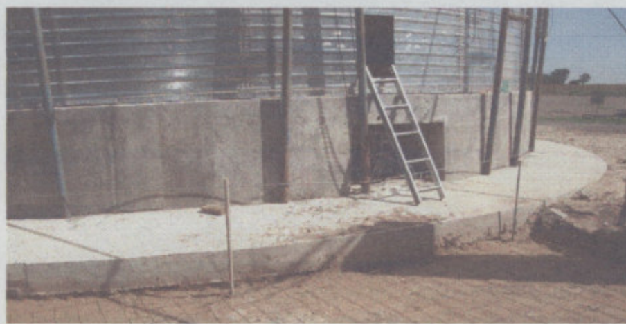
Fig. 5 – Obra civil de silo fondo plano-Fuste y vereda perimetral
