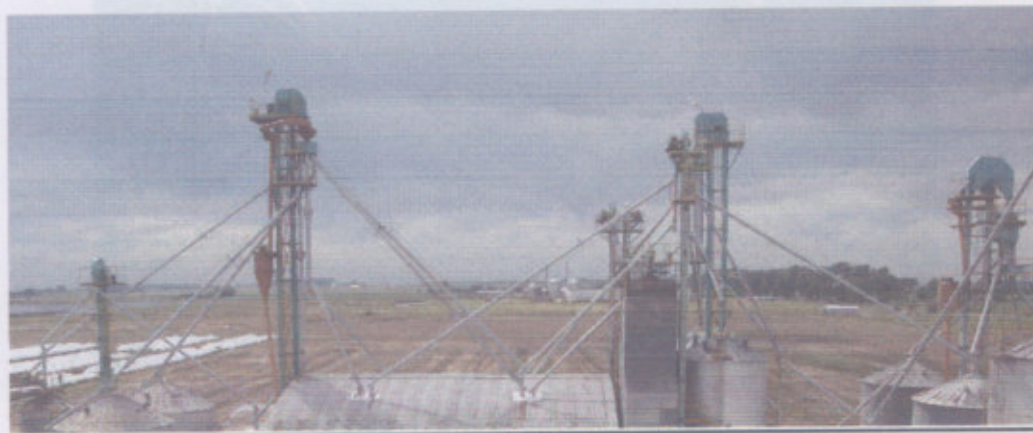
Fig.94- Cañería de conexionado
