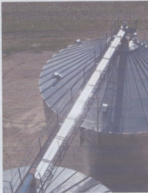
Fig.77- Pasarelas de servicio para transportes aéreos
