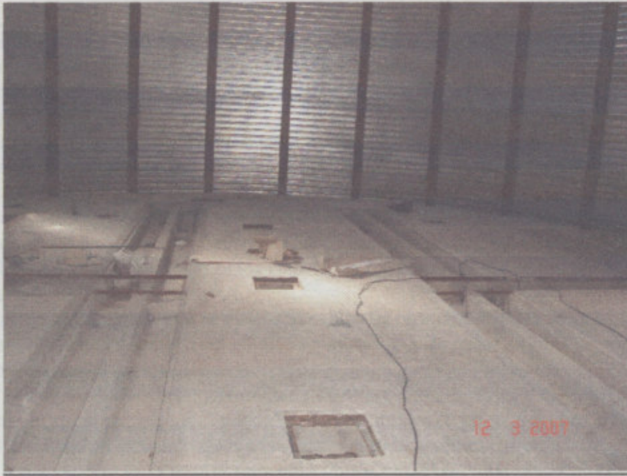
Fig. 9 –Silo de depósito-Capacidad 1450 TN-Estructura de cilindro
