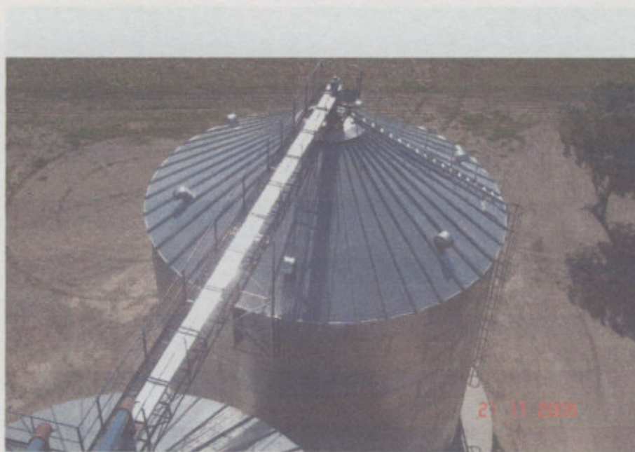
Fig. 7 –Silo de depósito-Capacidad 1450 TN-Cobertura de techo
