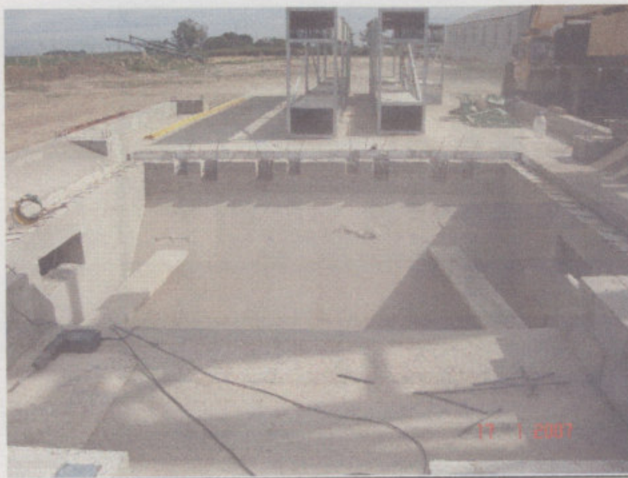
Fig. 17 -Obra civil- Tolva-Rejilla-Plataforma Volcadora
