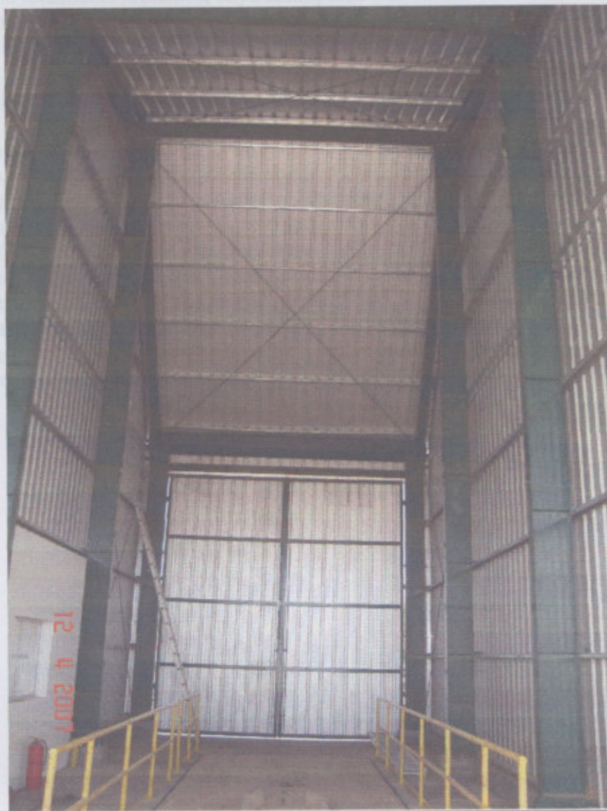
Fig. 47-Galpón Cubretolva –Vista interior
