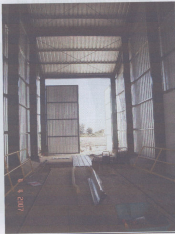
Fig. 42 –Galpón Cubretolva –Colocación de portones
