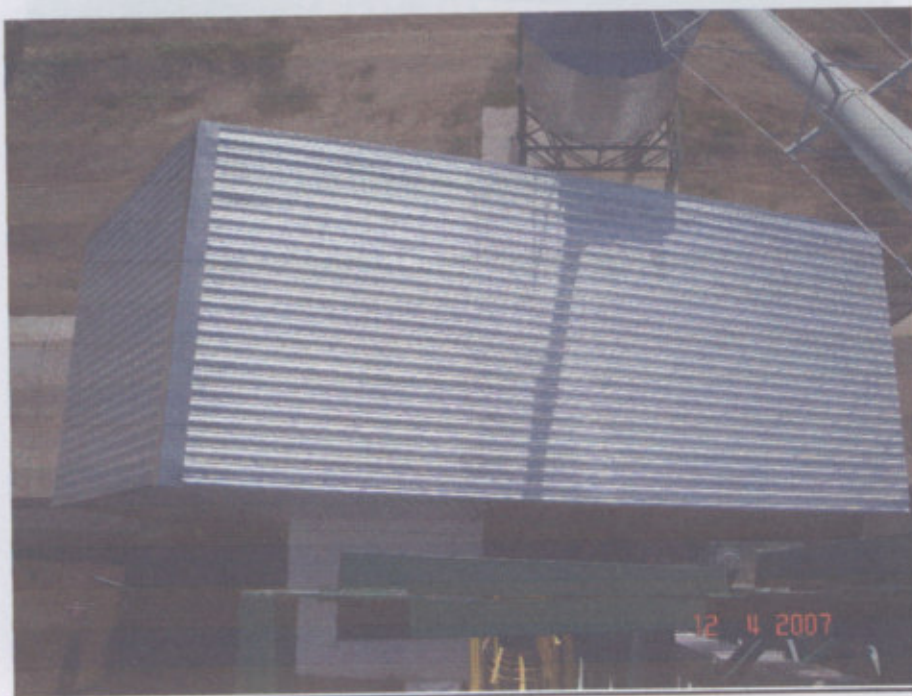
Fig. 46-Galpón Cubretolva –Vista aérea
