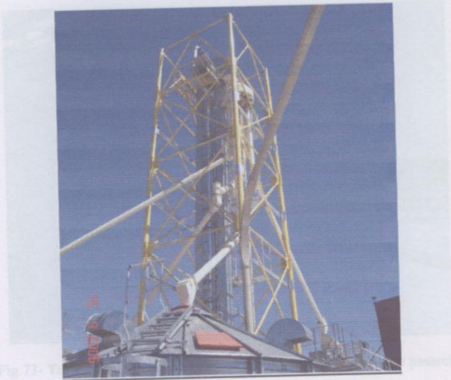
Fig. 71- Torre autoportante para elevador a cangilones
