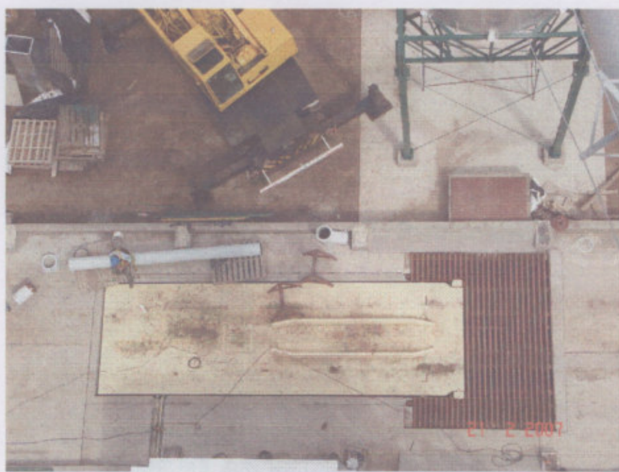
Fig. 33 -Rejilla de Tolva y plataforma volcadora
