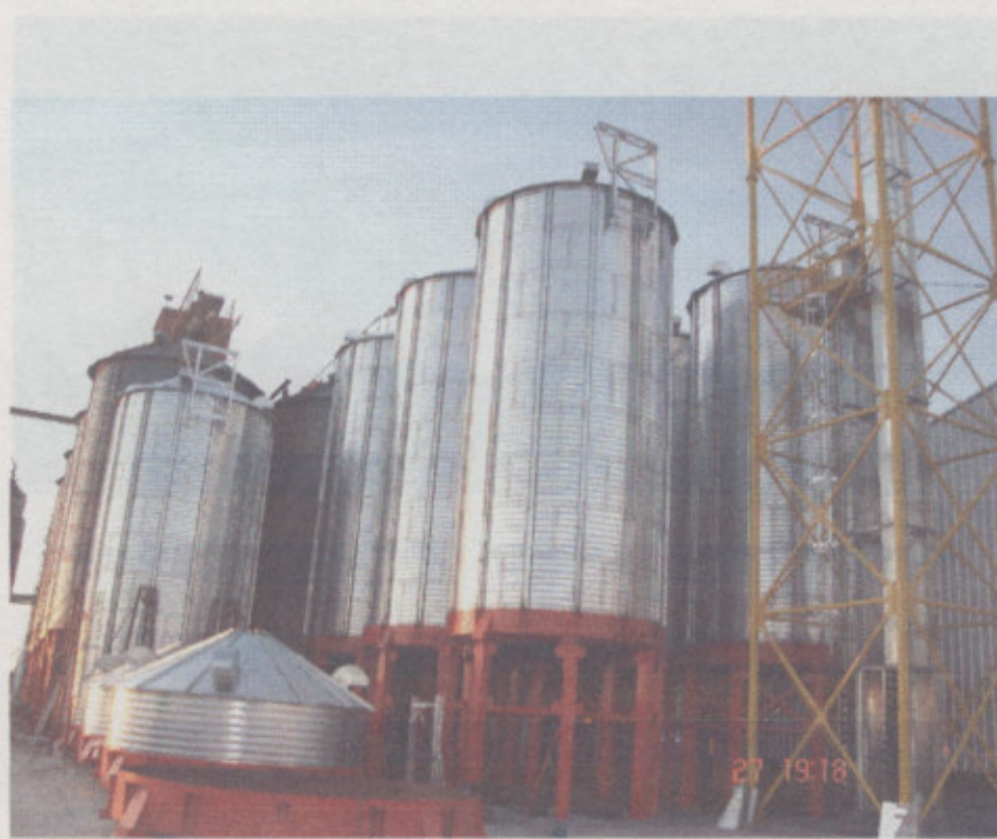
Fig. 12 –Silos de Húmedo y Tempering-Montaje
