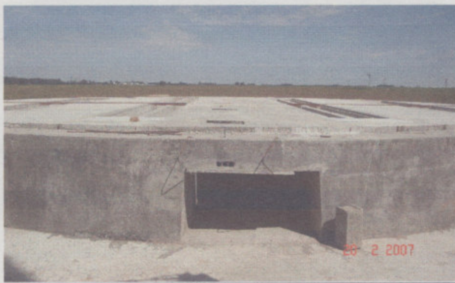
Fig. 3 – Túnel para transporte de vaciado silo
