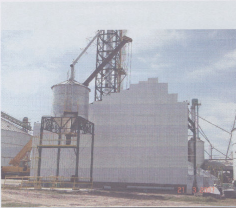
Fig. 39 –Galpón Cubretolva –Colocación de chapas laterales
