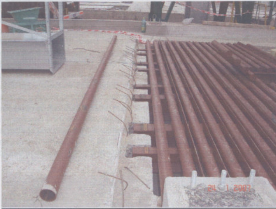
Fig. 36 –Rejilla de Tolva durante su construcción
