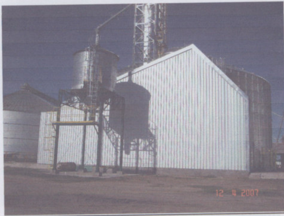
Fig. 45-Galpón Cubretolva –Vista lateral
