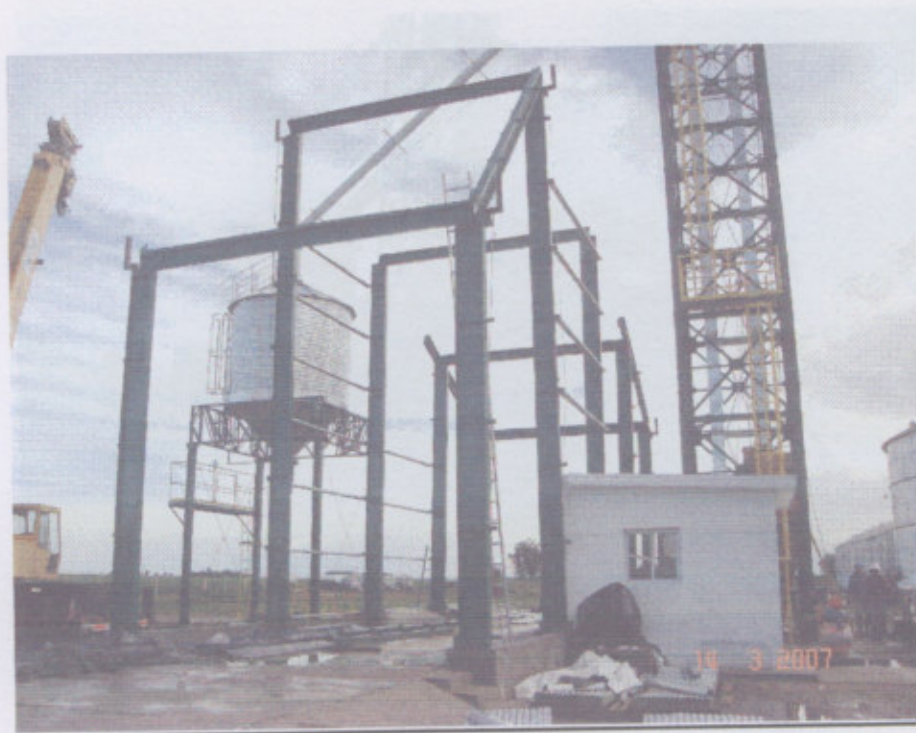
Fig. 37 -Galpón Cubretolva -Estructura de alma llena
