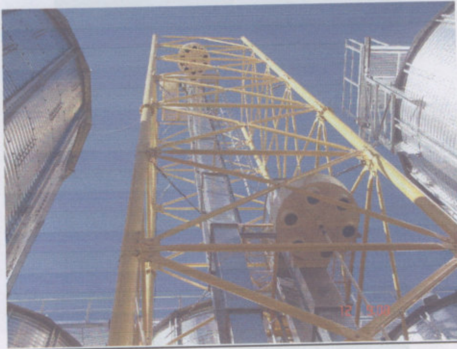
Fig. 69- Torre autoportante para elevador a cangilones
