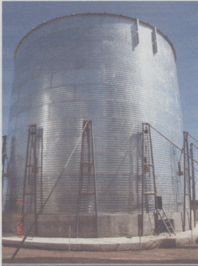
Fig. 6 – Montaje de silo fondo plano
