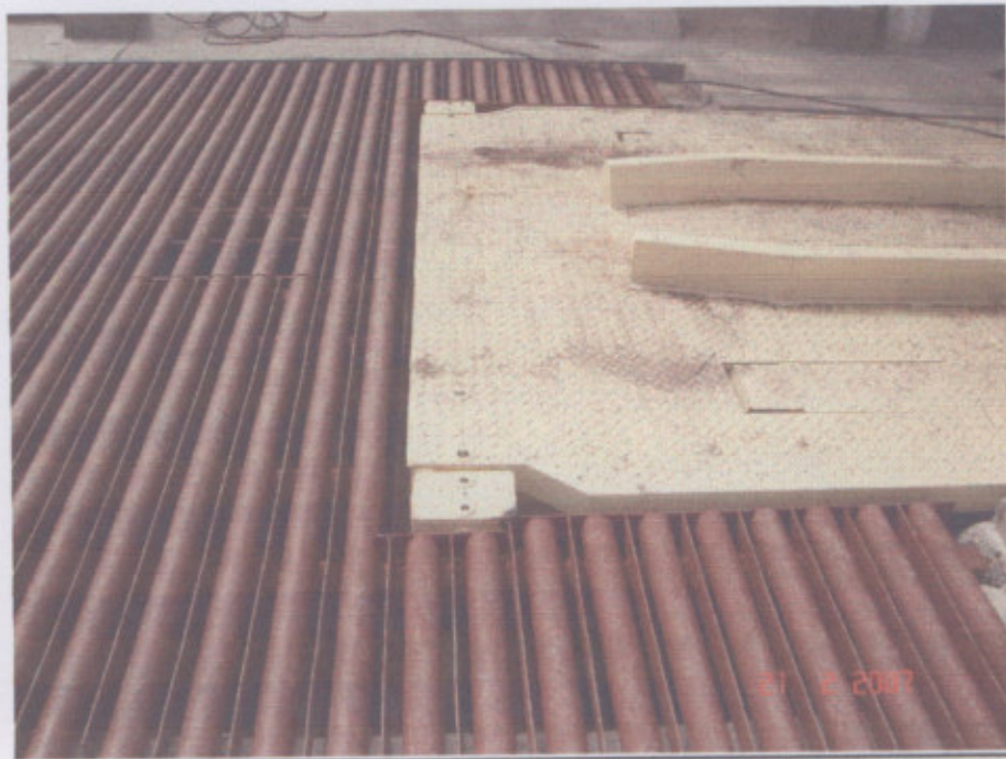
Fig. 35 - Rejilla de Tolva y plataforma volcadora
