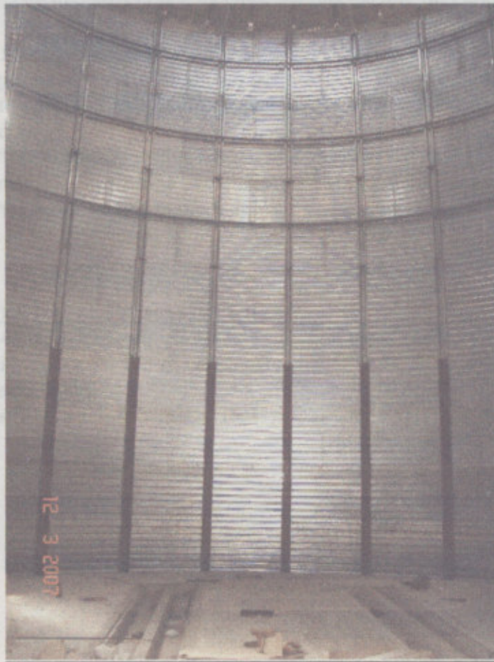
Fig. 10 –Silo de depósito-Capacidad 1450 TN-Estructura de cilindro
