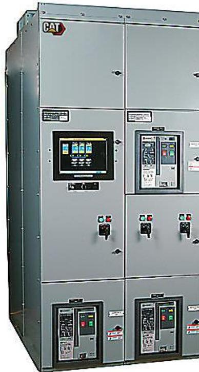
**Figura 46** - Equipo de conmutación y controles en paralelo XML
