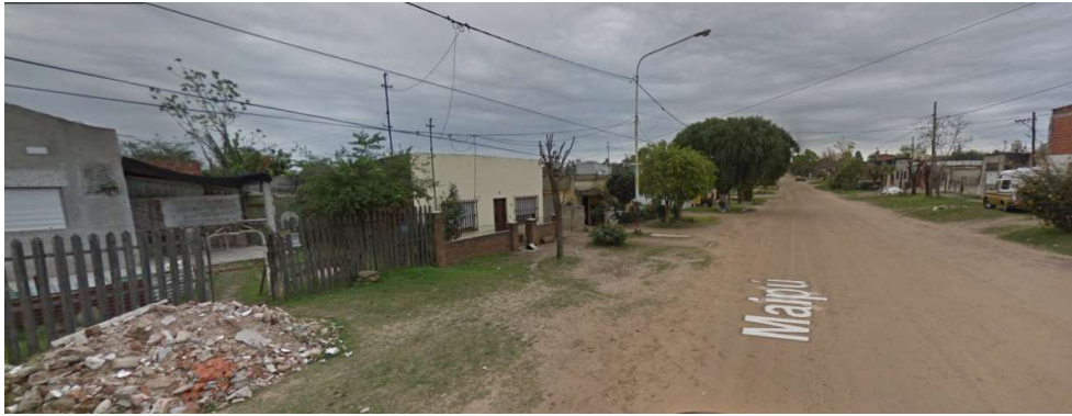
Fig. 2—2. Estado de las veredas calle Maipú
