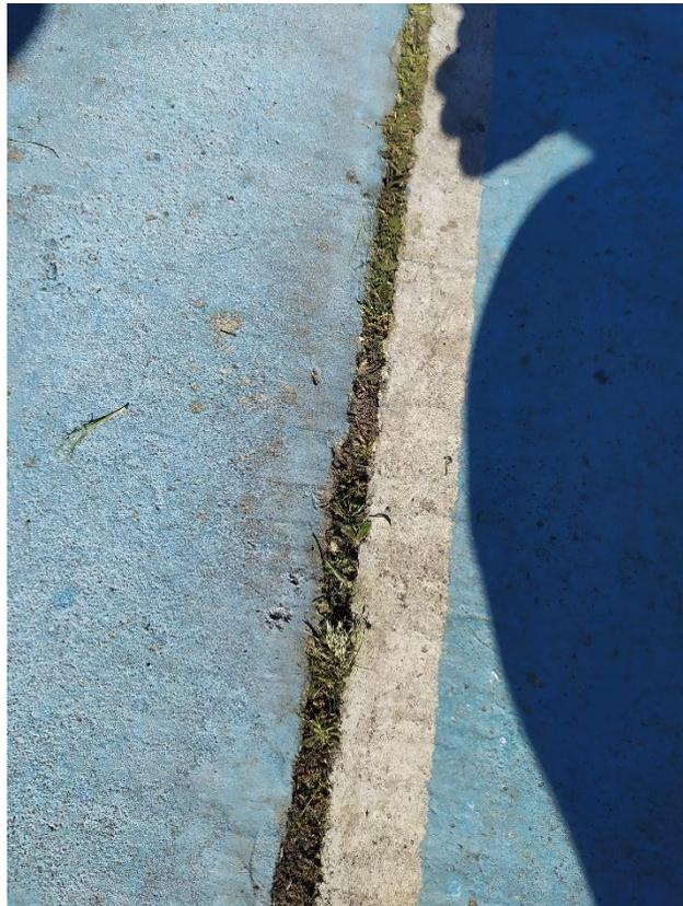
*Figura 4-6. Estado de juntas de dilatación y contracción.*
