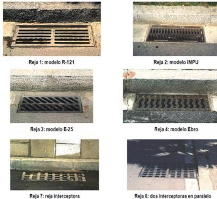
**Figura I.3.2.:** Tipos de rejillas interceptoras
