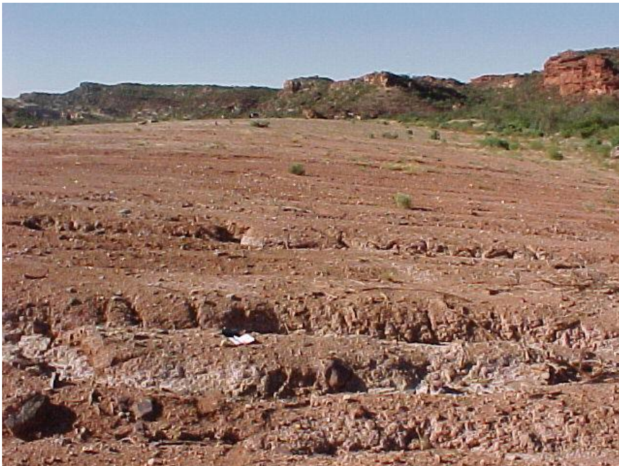
Erosión en la Cubierta de la Pila.
