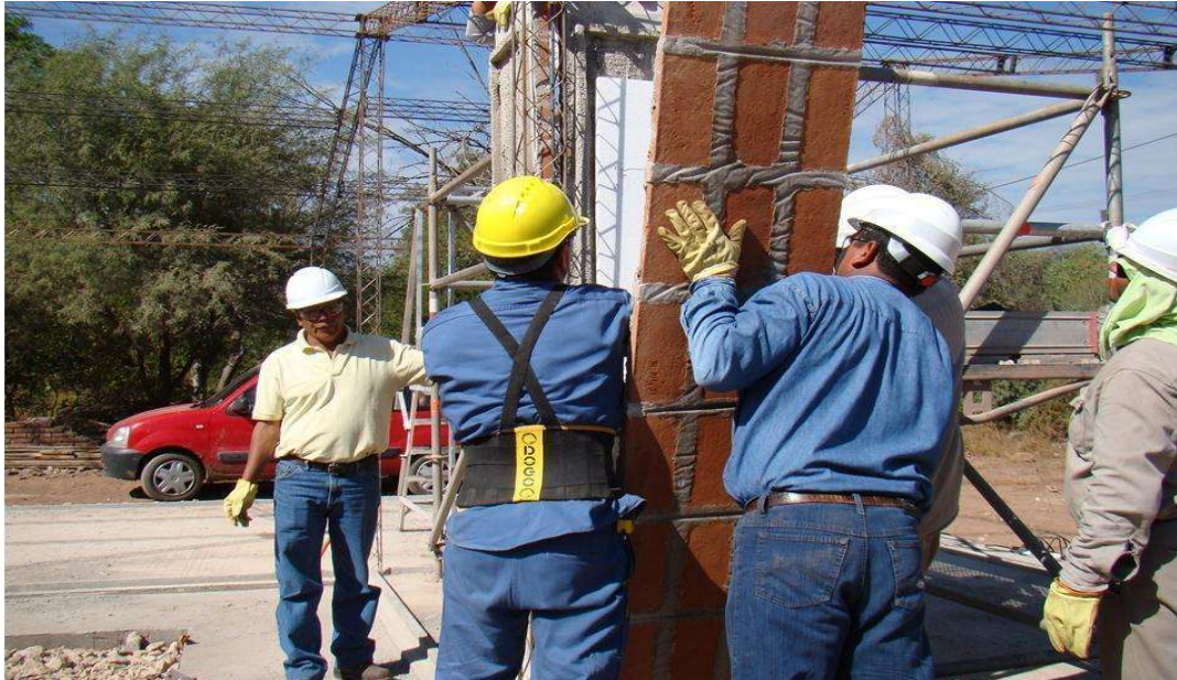
Vivienda unifamiliar construida mediante el método BETO 46
