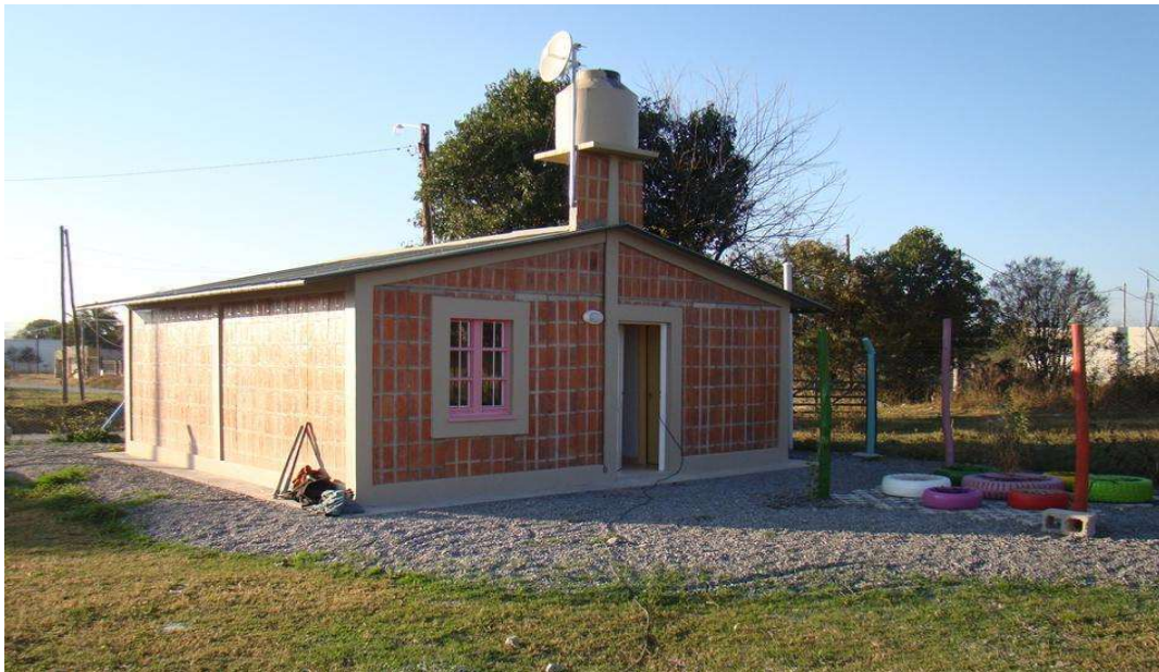
Vivienda unifamiliar terminada sin revoque exterior 47
