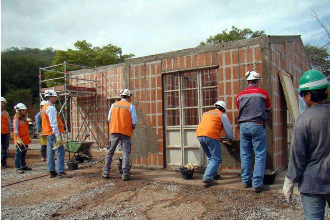
Vivienda unifamiliar construida mediante el método BENO 45
