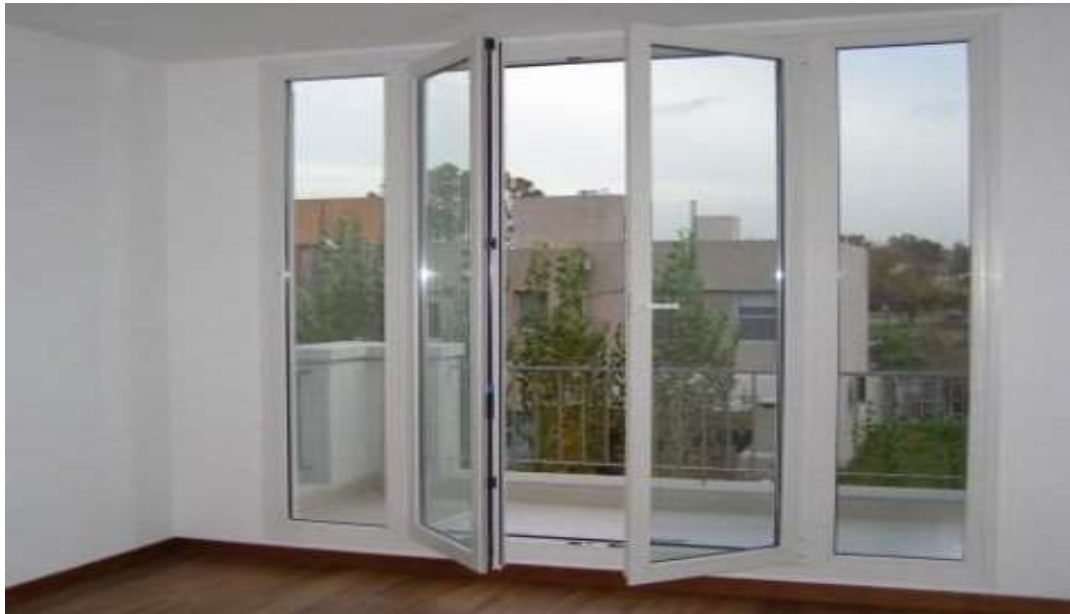
Abertura ventana-balcón, doble vidrio con marco de aluminio 40
