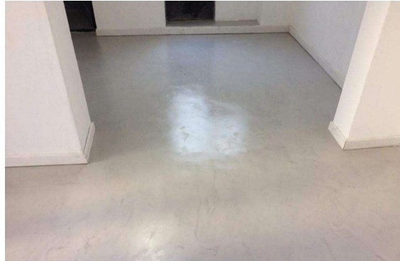
Imagen acabada de cemento alisado 37
