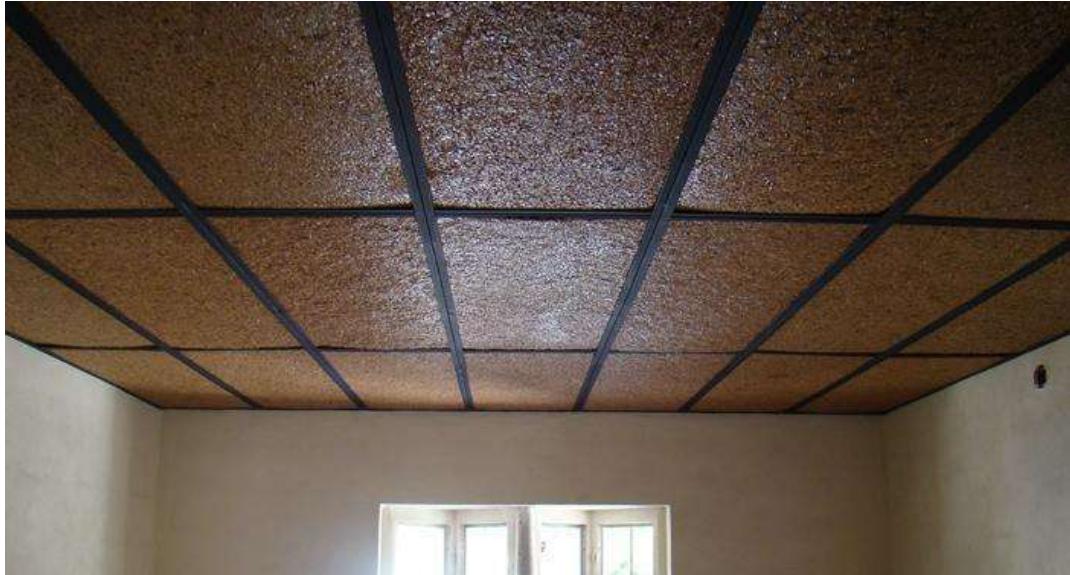
Cielorraso suspendido utilizando paneles de cáscara de mani 36
