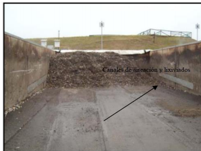
Gráfico 7: Canales de aireación y lixiviados (Roggio, R. (2011), EIA- Proyecto de tratamiento y reducción de RSU- Planta de TMB- CEAMSE)
