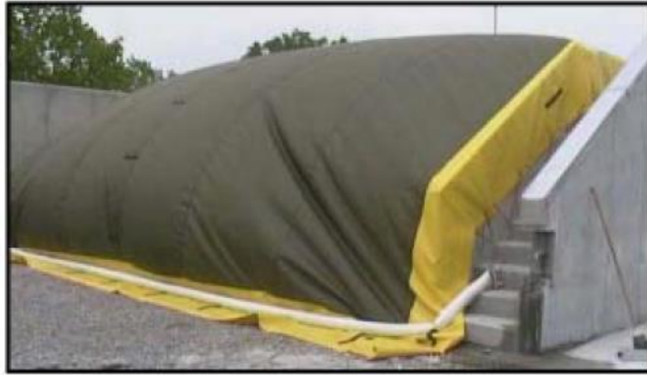
Gráfico 6: Membrana GORE (Roggio, R. (2011), EIA- Proyecto de tratamiento y reducción de RSU- Planta de TMB- CEAMSE)
