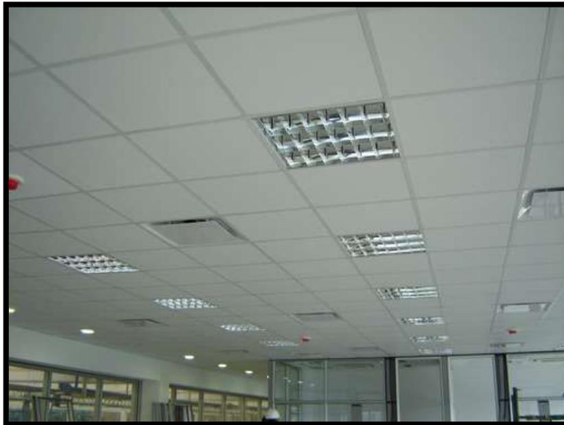
*Figura 129 - Cielorraso desmontable de yeso.*
