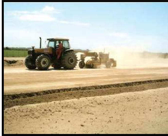
*Figura 223 - Barrido y soplado de la superficie de la base de suelo cemento.*
