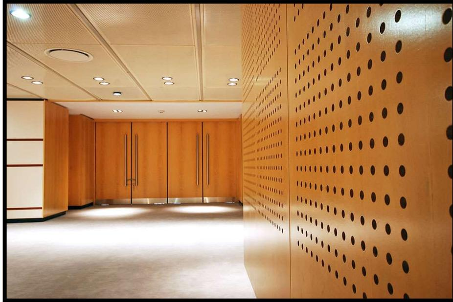
*Figura 139 - Paneles acústicos perforados.*
