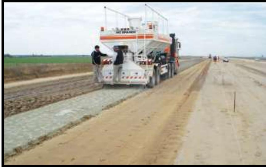
*Figura 220 - Distribuidor de cemento.*
