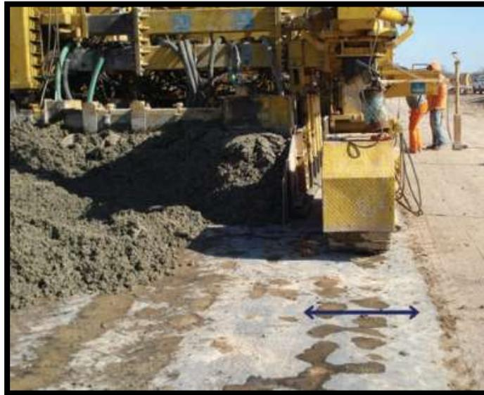
*Figura 217 - Sobrecancho constructivo para el tránsito de las orugas de los equipos de pavimentos.
