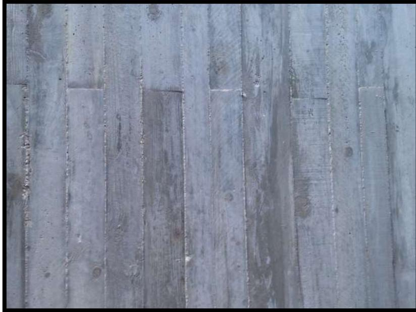
*Figura 137 - Textura encofrado de madera en muro de Hormigón Armado.*
