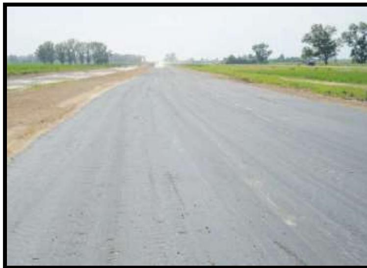
*Figura 222 - Riego asfáltico de curado.*
