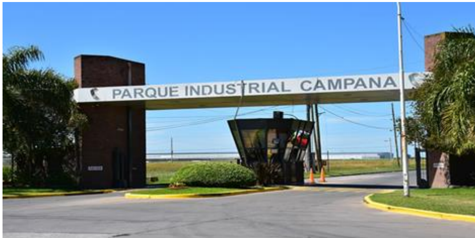
Figura 8 – 3.1. Ingreso al Parque Industrial
