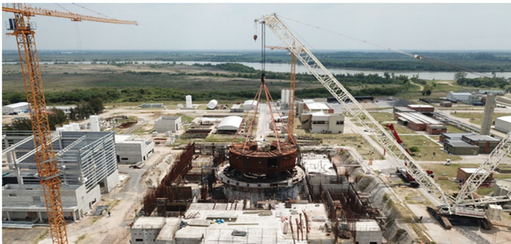
Figura 7. Noviembre de 2020. Instalación del módulo 10 del liner de contención. Fuente: https://www.argentina.gob.ar/cnea/carem/la-construccion-del-carem-en-fotos
