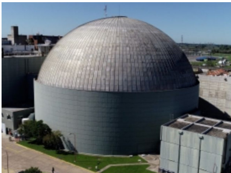
Figura 12. Domo de contención de la CNA II.
