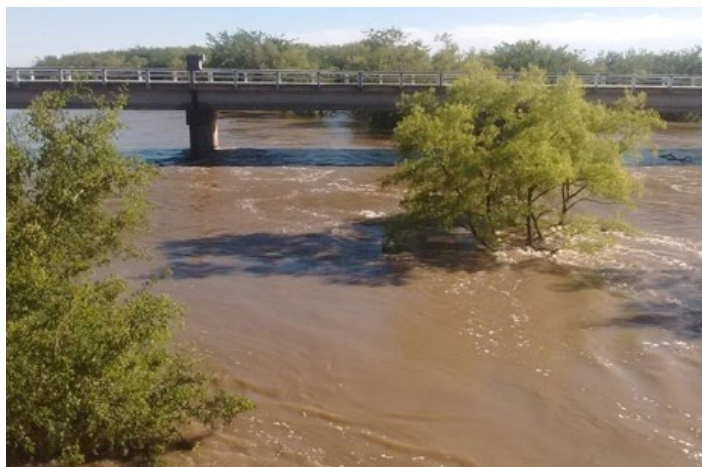
Figura 1.3. Desborde del arroyo Nogoyá. Ruta Nacional N°11. Febrero 2016.
