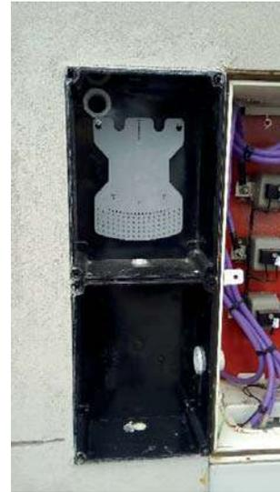
Para estos casos, el gabinete para la Microgeneración puede estar resuelto a través de una caja de 60 cm de alto x 25 cm de ancho x 20 cm de profundidad, o a través de dos caja modulares como las admitidas en el punto anterior.
