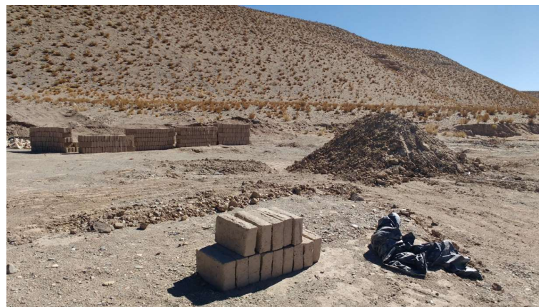
Figura 2.5 Lugar donde se fabrican adobes en San Antonio de los Cobres
