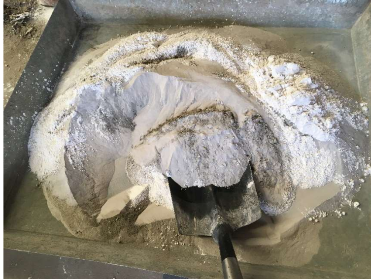
Figura 4.2 Mezclado manual de los materiales en seco
