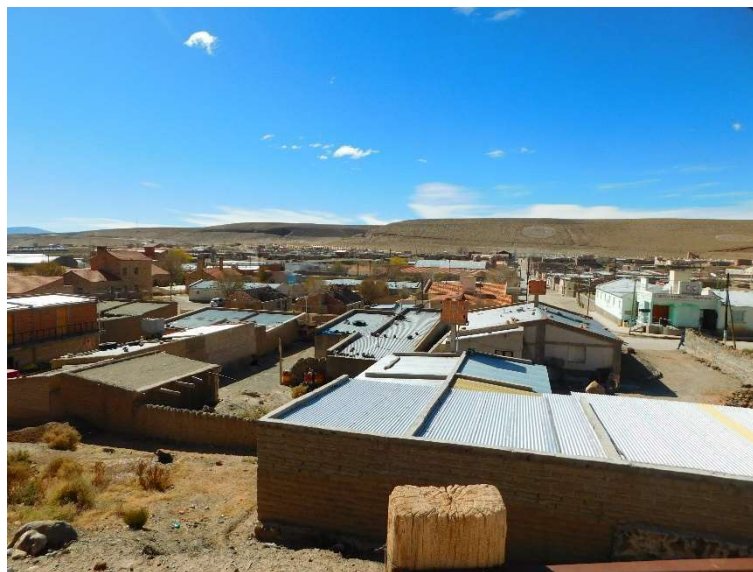
Figura 2.3 Distintas cubiertas en viviendas de adobe
