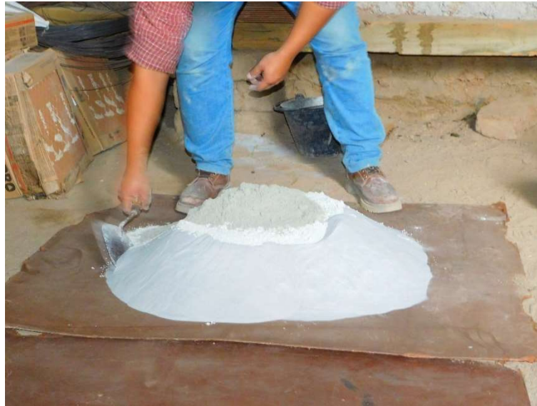
Figura 7.3 Mezclado de las proporciones en seco
