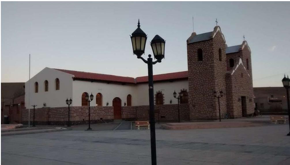
Figura 2.2 Iglesia de San Antonio de los Cobres con bases de piedras y adobes pintados
