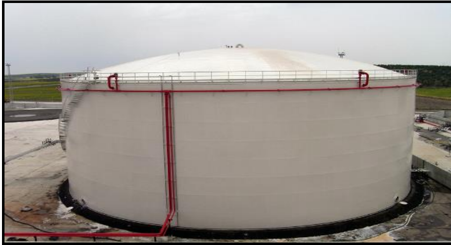
Ilustración 79 - Tanque atmosférico de techo fijo.
