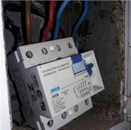
*Nota: Se puede observar que el estado del tablero no está en condiciones junto con algunos conductores y colores normalizados.*
