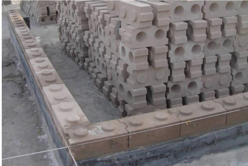
Figura 8: Inicio de una construcción con BTC encastrables producidos por los pobladores mediante el empleo de una prensa “Mattone” en el Nochero, Santa Fe. Fuente: Ariel González, 2008.
