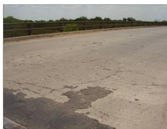
Fig. 3 Vista Superior actual del puente (izq.) y de fisuras en la losa del tablero superior antes de ser re-asfaltado (der.).
