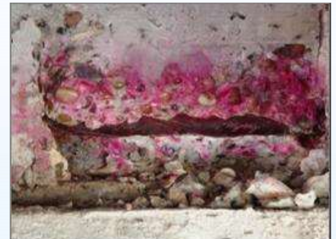
Ensayo de carbonatación sobre viga principal
