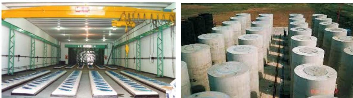
Fig. 4: Combustible nuclear almacenado en condiciones húmedas (izq.) y combustible nuclear almacenado en silos de hormigón en condiciones secas (der.) (Fuente: Jornadas Argentinas de Protección Radiológica – SAR 2012 – Gestión de Residuos Radiactivos: Desafíos Actuales. Elvira Maset [15])
