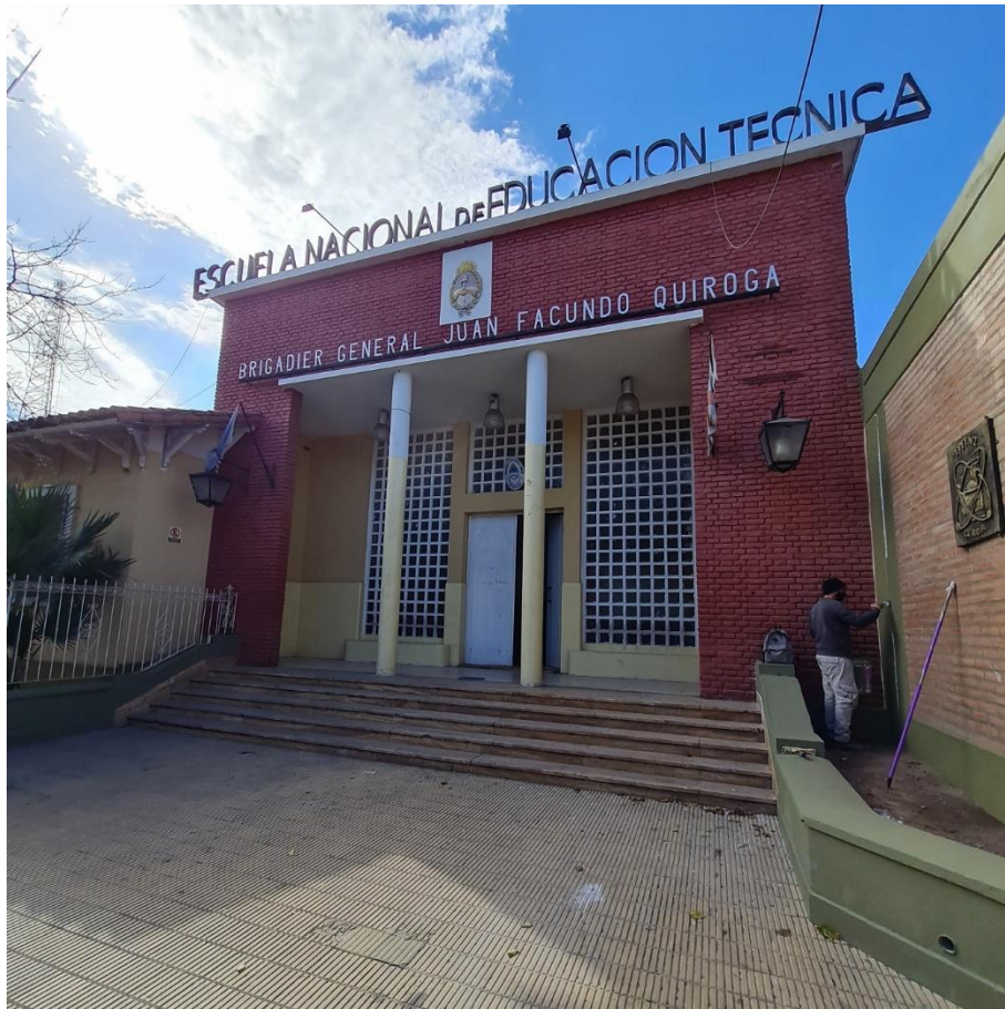
Puerta de ingreso principal
