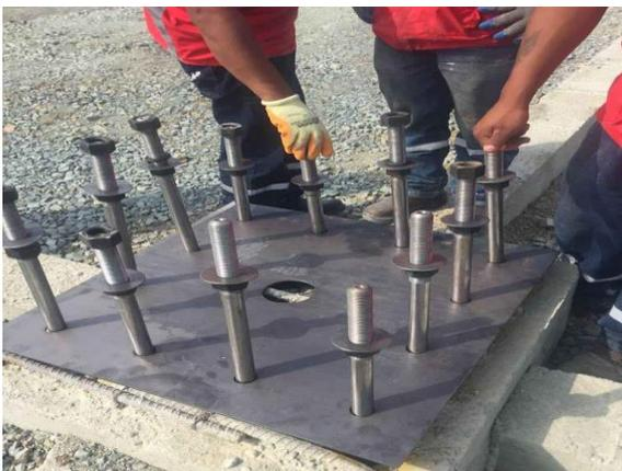
Figura 9.2 colocación de pernos de anclaje
