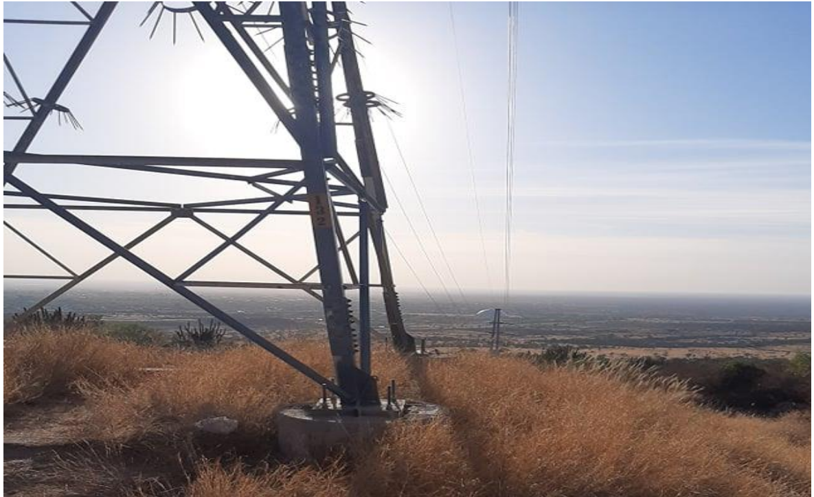
Figura 5.18 línea de alta tensión - Vista desde cerro Morro
