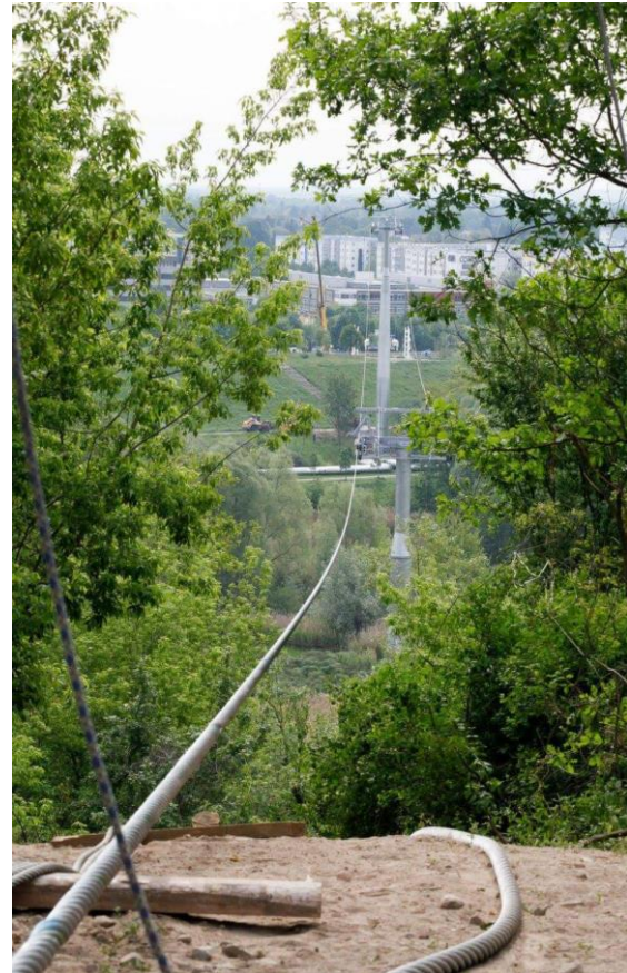
Fotografía 3.5 Montaje de cable de Acero.
