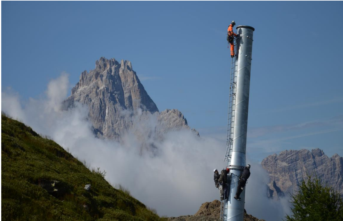
Fotografía 3.8 Montaje de tronco de torre
