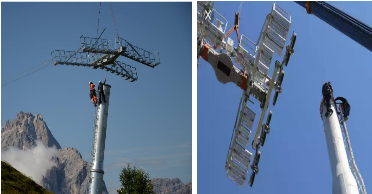
Fotografía 3.11 Montaje de balancines sobre torre soporte.
