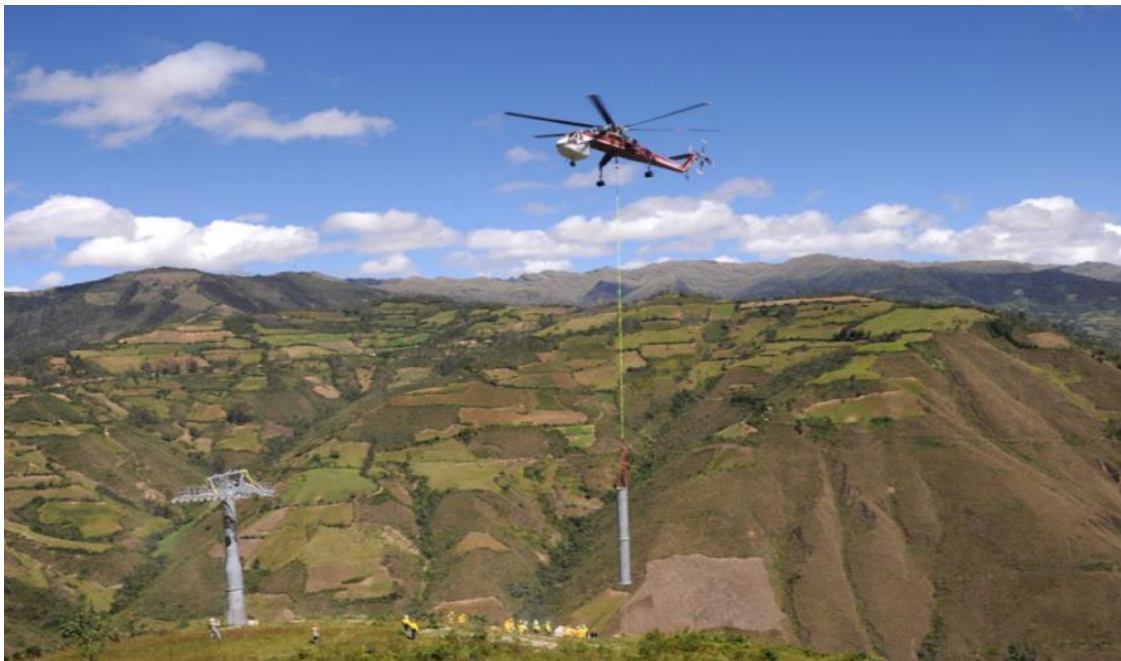
Fotografía 3.7 Montaje de tronco de torre
