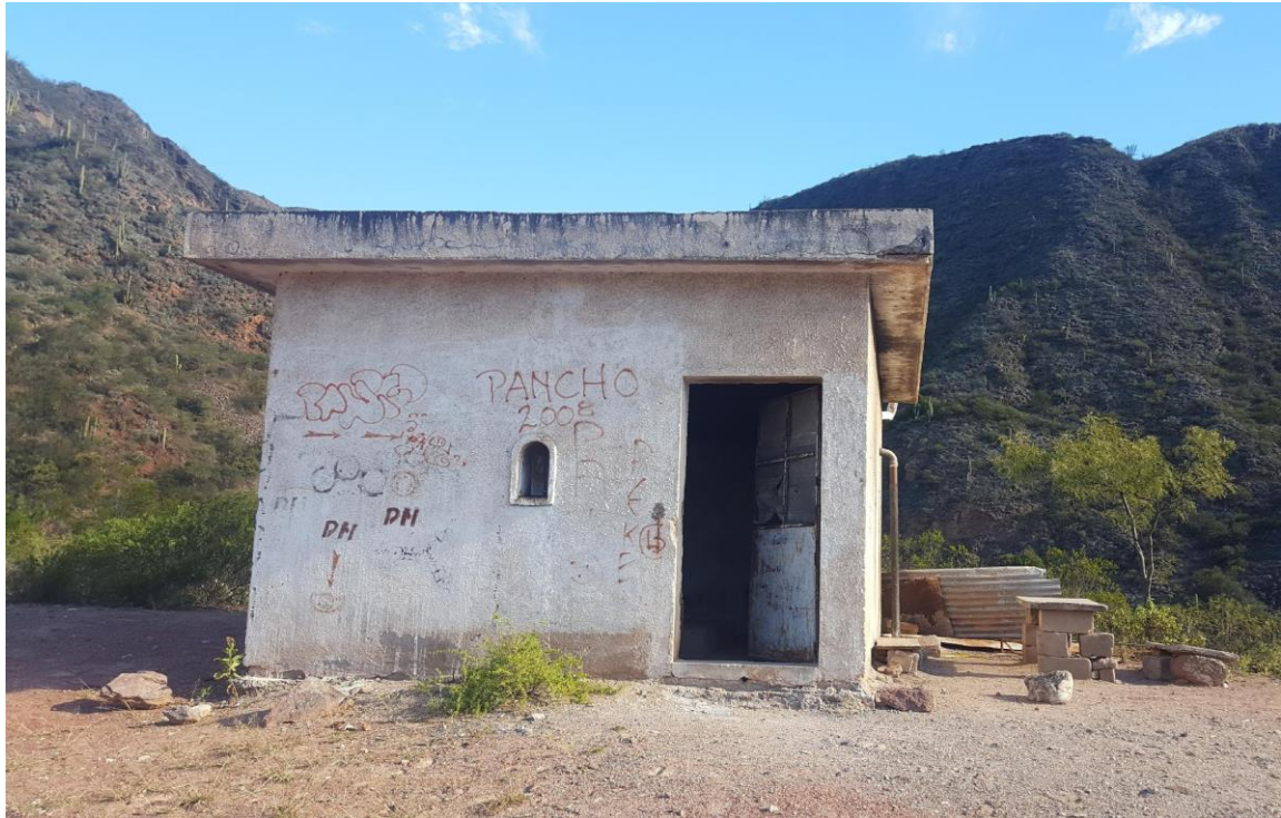
Figura 5.14 Sala de bombas - Cerro El Morro
