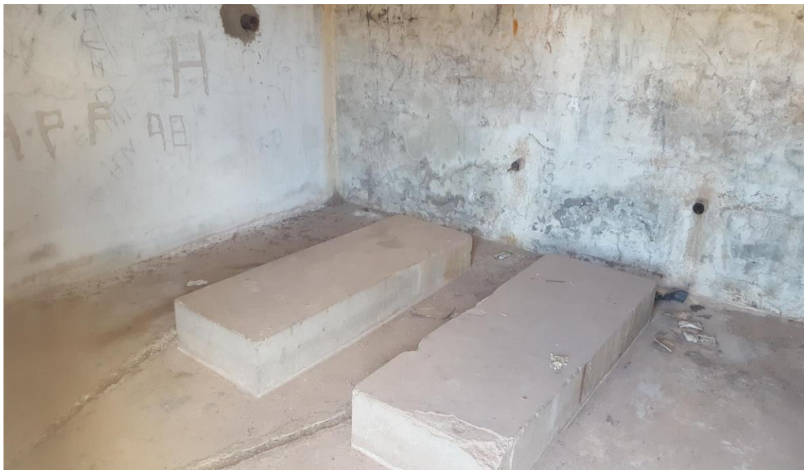
Figura 5.15 Sala de máquinas – Cerro “El Morro”
