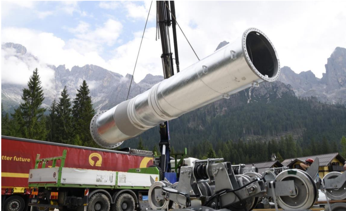
Fotografía 3.6 Transporte de torres a lugar de emplazamiento.
