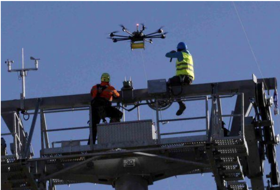
Fotografía 3.4 Tendido de cable guía. Mi Teleférico- La Paz.
