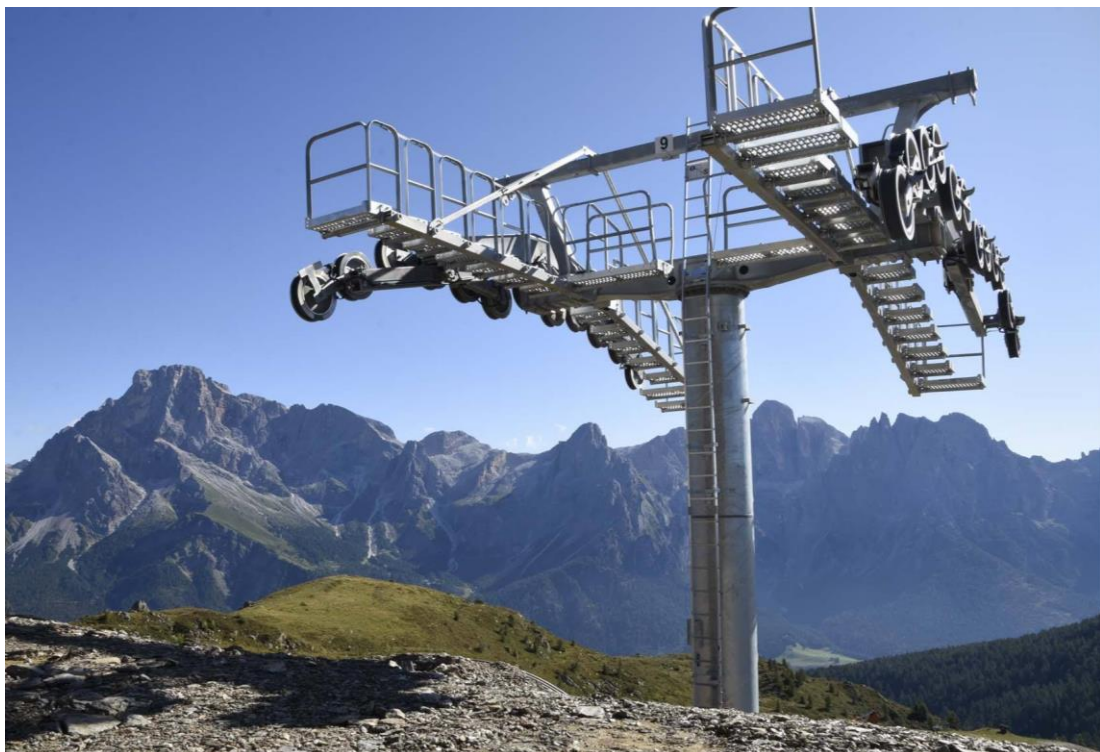
Fotografía 3.9 Torre tubular de Acero
