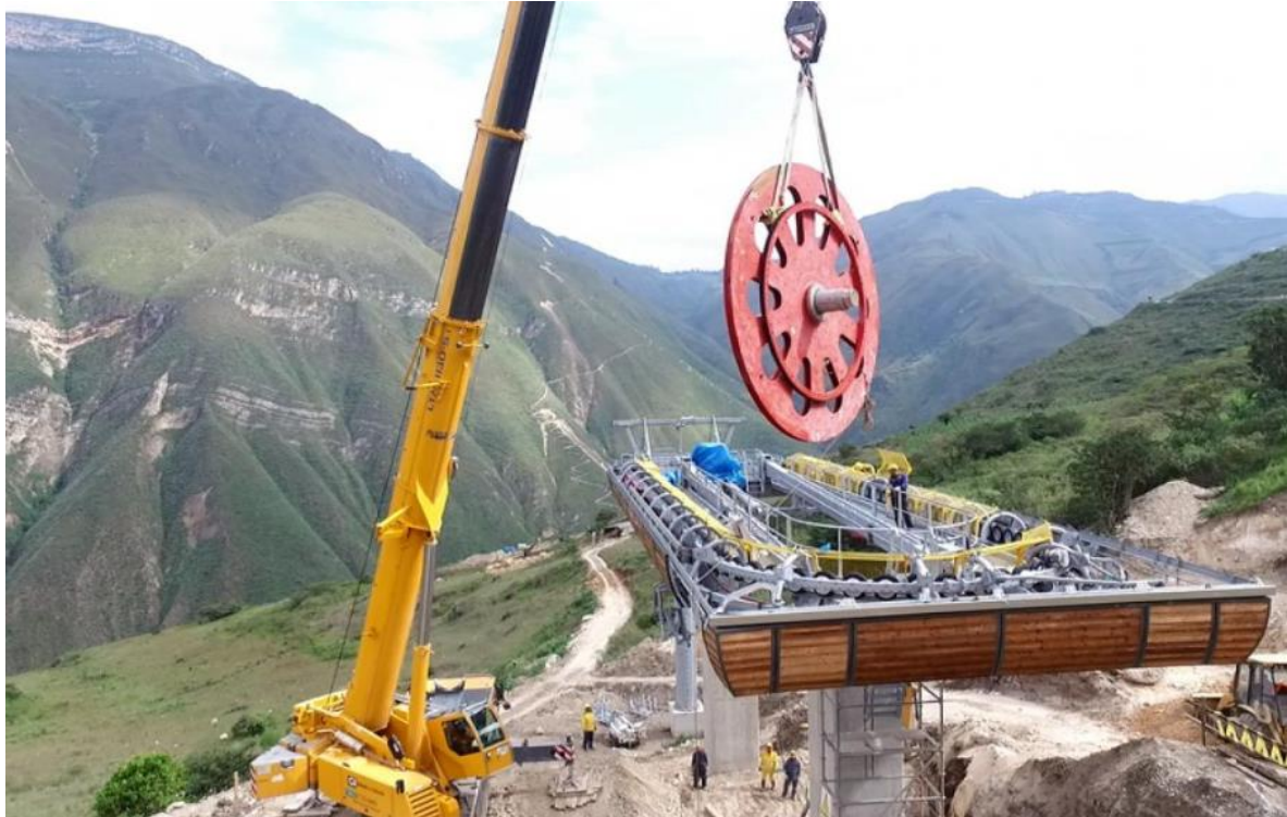
Figura 4.8 montaje de estación de llegada
