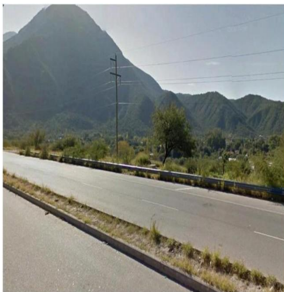
Figura 5.16 línea de media tensión en servicio
