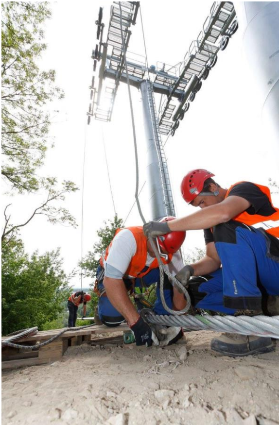
Fotografía 3.5 Montaje de cable de Acero.
